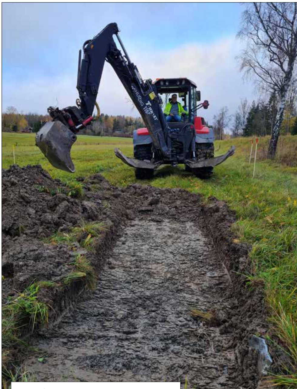
Figur 3. Schaktning med traktorgrävare vid objekt 3. Foto från söder.
