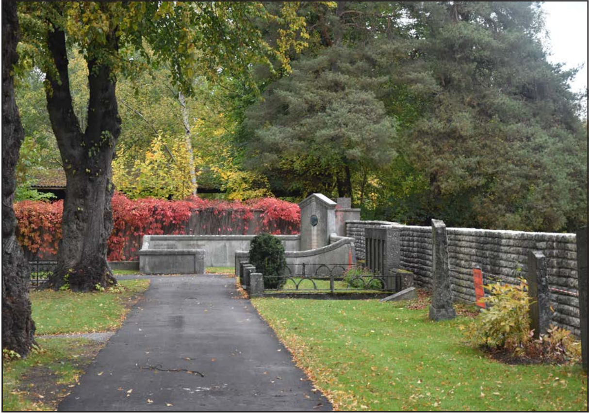
Figur 23. Pågående arbete 2021-09-29. Muren sedd från kyrkogården.
