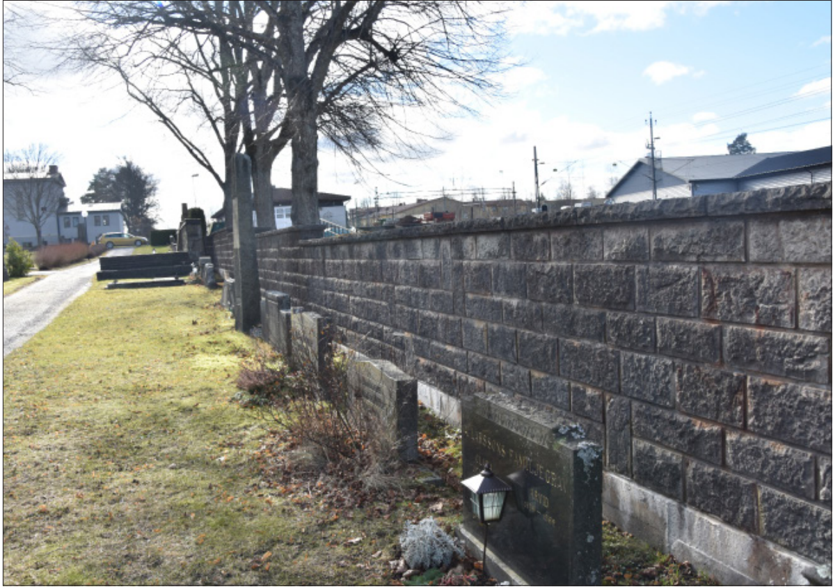
Figur 11. Etapp 1, Muren mot nordväst före renovering i mars 2021.
