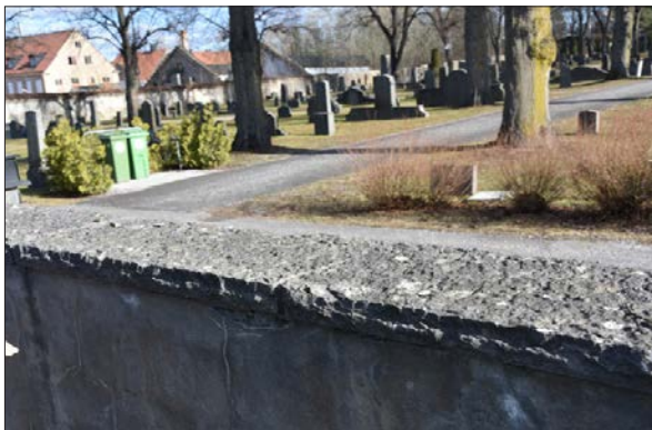
Figur 9. Detalj av lock och utsidan av muren som är putsad.
