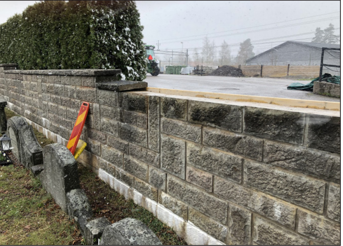
Figur 20. Locken återmonteras lutande, så att vattnet kan rinna av.
