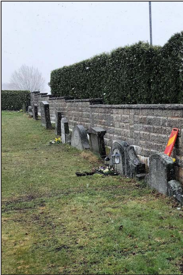
Figur 16. April 2021. Onvädet gör det svårt att fotografera. Men en del av muren är renoverad.
