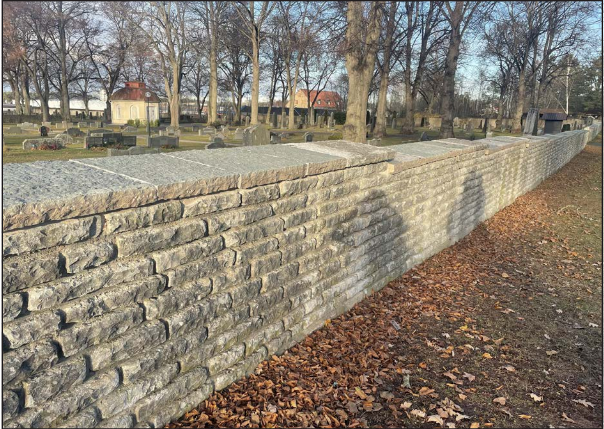
Figur 24. Slutbesiktning av den röda muren i november 2022.
