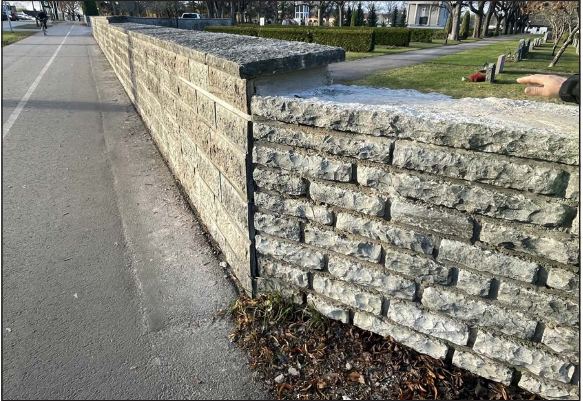
Figur 27. Slutbesiktning november 2022. Hörnet där röd mur möter orange mur. Locken räckte inte. Fler stenar från Öland är beställda och arbetet fortsätter våren 2023.
