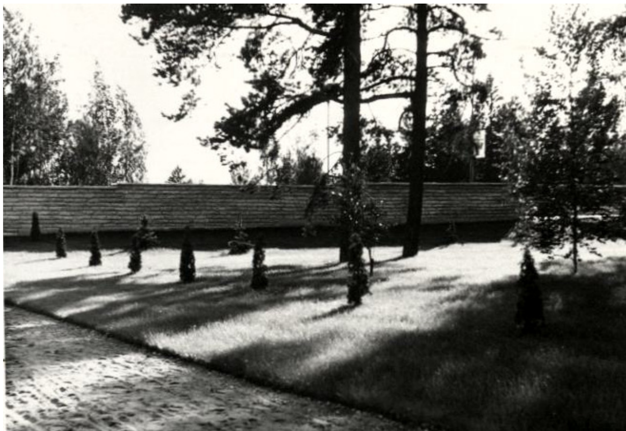
Figur 6. Den första delen av muren uppfördes 1957. Källa: Riksantikvarieämbetets arkiv.
