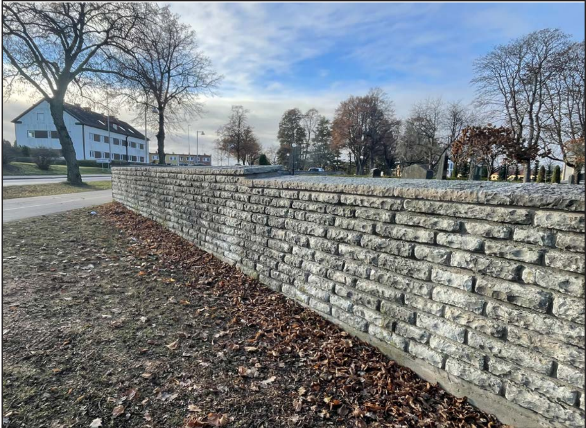
Figur 26. Utsikt mot Vingåkersvägen. Denna del av den röda muren klar. November 2022.
