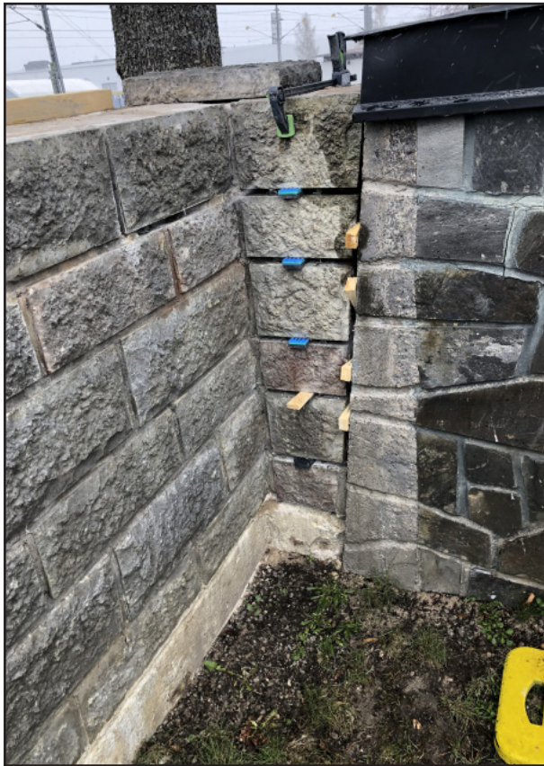
Figur 14. Arbetet med muren har påbörjats mars 2021.
