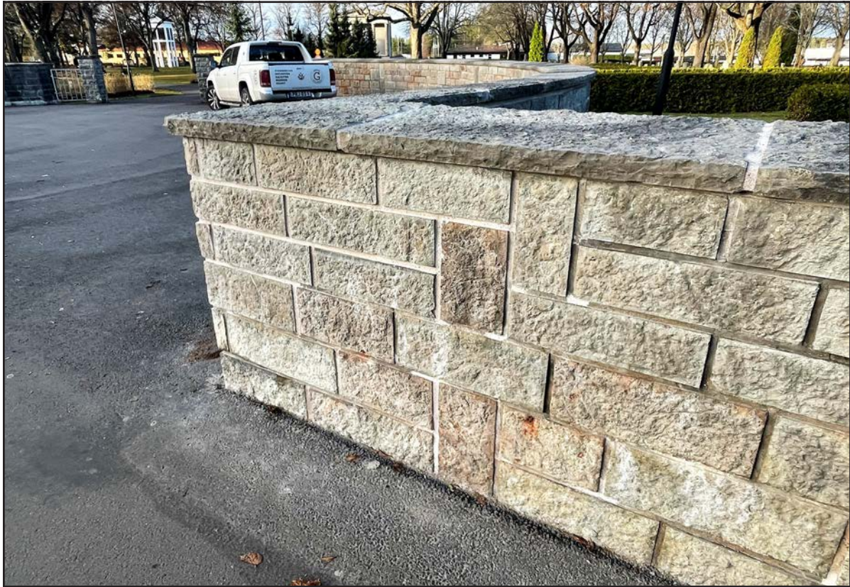
Figur 31. Orange mur omgärdar kyrkogården mot Vingåkersvägen. Arbetet med denna del av muren är påbörjat. Utfört till belätnhet. Snygga fogar. Arbetet fortsätter 2023, vid grindarna där bilen står.
