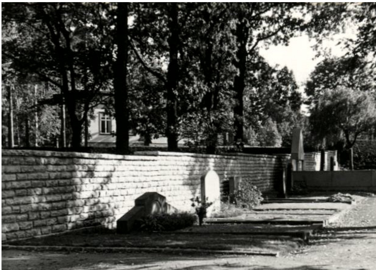
Figur 5. Fotografiet togs i samband med ansökan om tillstånd till att uppföra muren, trots att arbetet redan påbörjats. Äldre fotografi från 1958. Källa: Riksantikvarieämbetets arkiv.
