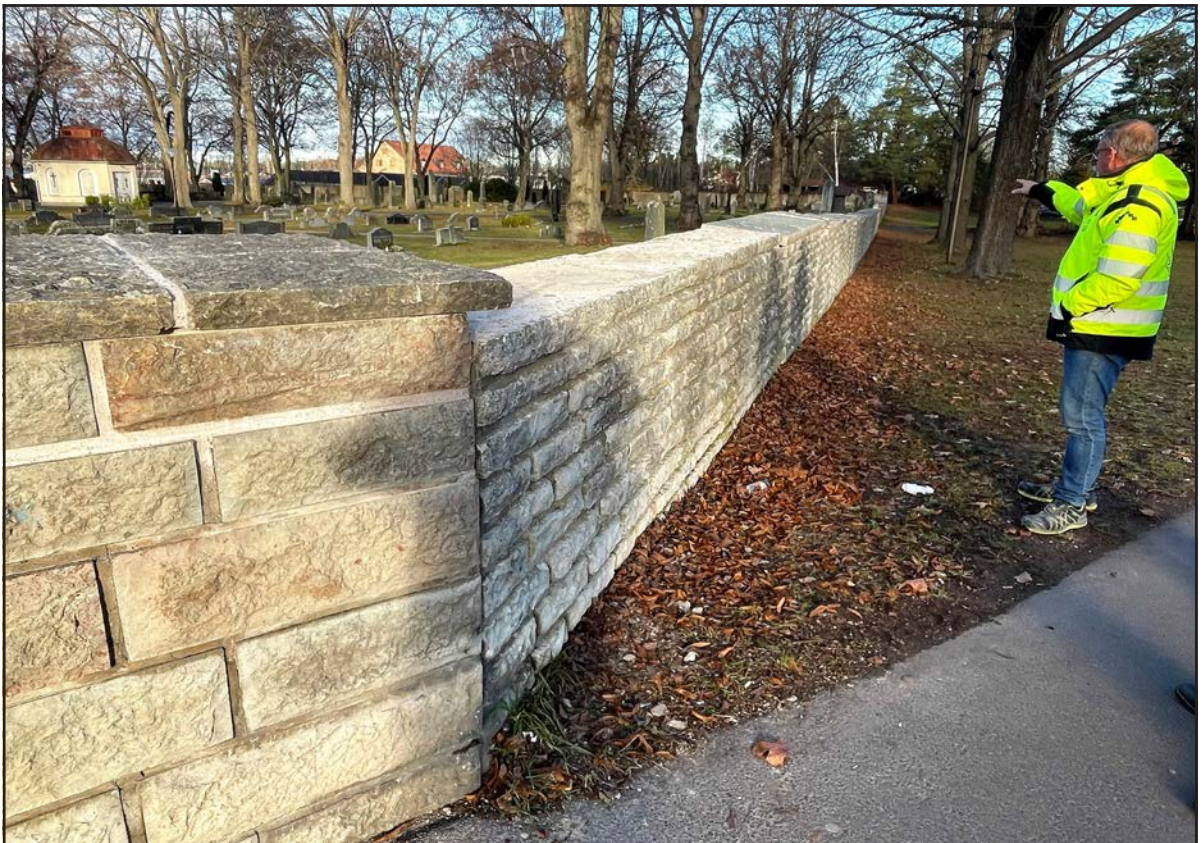
Figur 28. Stefan visar, den sista delen av röda muren där locken behöver kompletteras samt den påbörjade orange muren. Lägg också märke till att nya fogar är lite ljusare i kulör, men det ser bra ut. Färgen kommer att mörkna.
