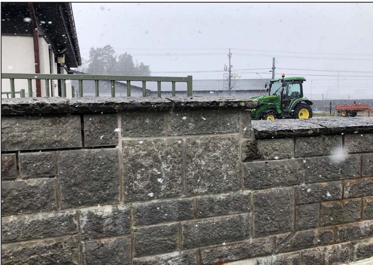
Figur 18. Detalj av mur i snöoväder. Återmonterade lock.
