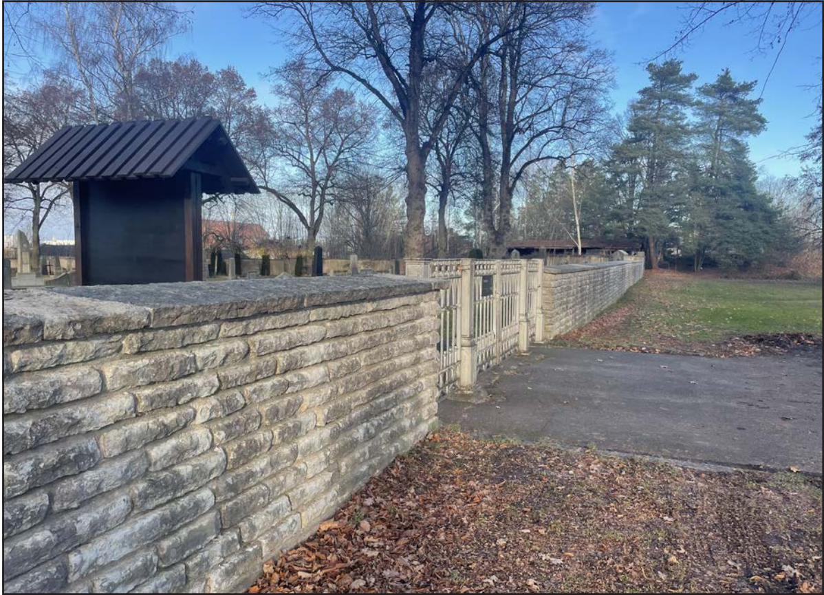
Figur 25. Slutbesiktning av den röda muren i november 2022. Utbytta lock stämmer bra med ursprungliga. Nya fogar stämmer bra med befintliga.
