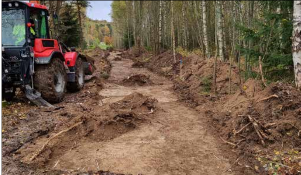
Figur 5. Schakt S883 under arbete. Foto från nordväst: Christian Gatti.
