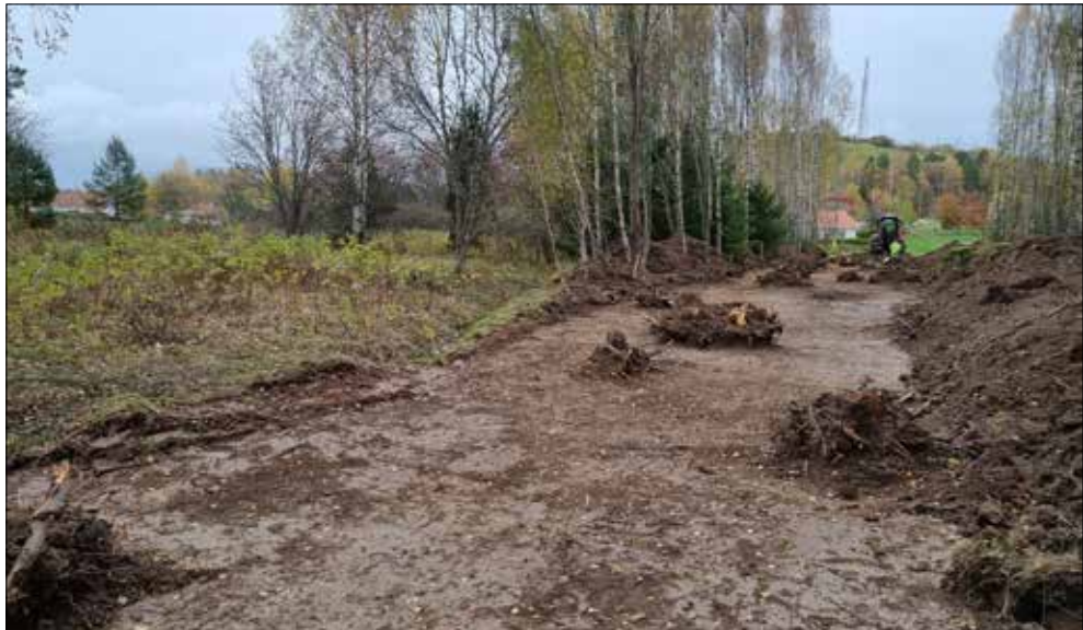
Figur 6. Schakt S883 som avgränsas av ett öppet dike (mitt i bilden). Cirka 40 meter till öster om schaktet är granfält L2002:3942 (vänster i bilden). Foto från nordnordväst: Christian Gatti.
