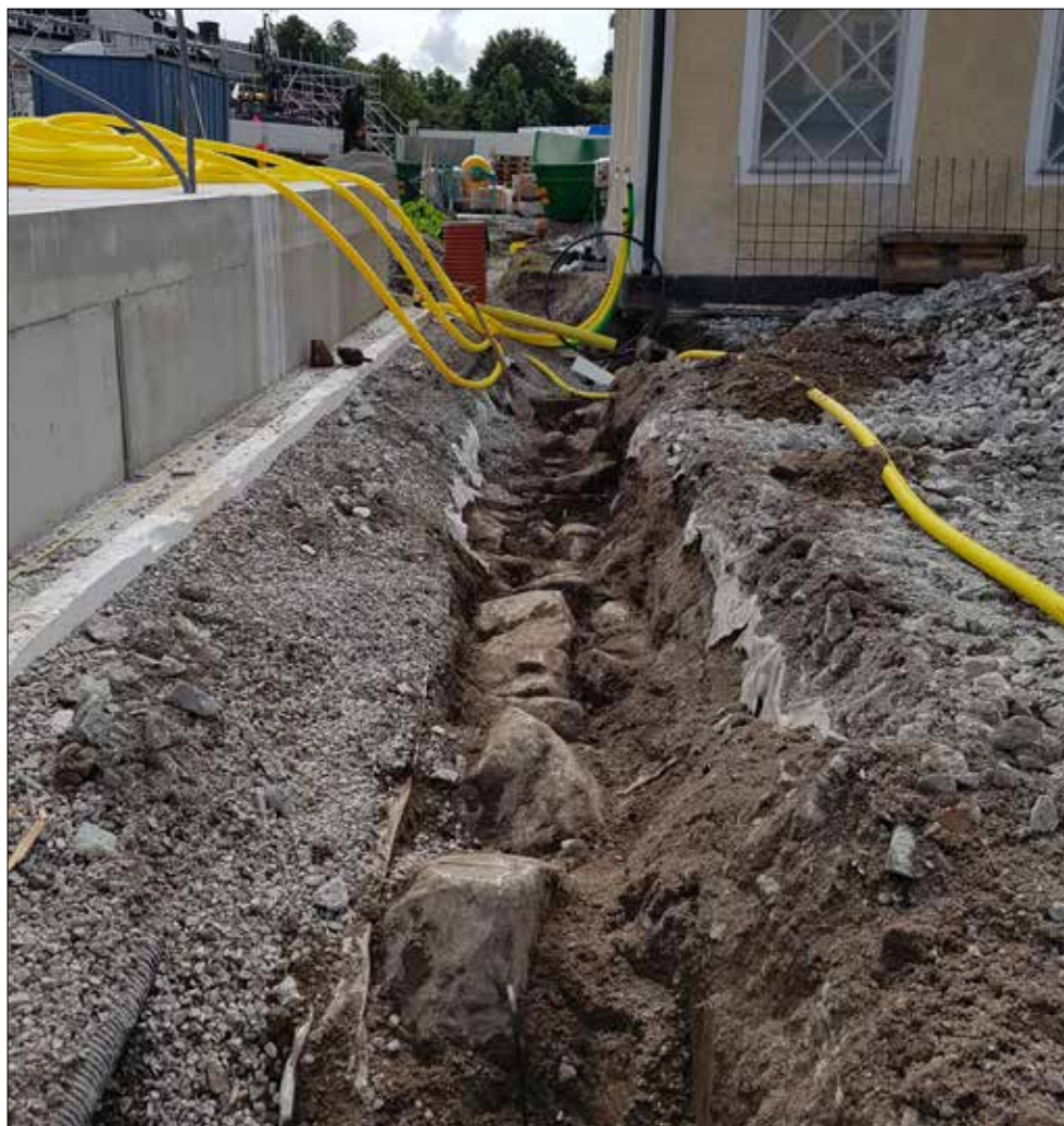
Figur 20. Husgrund A3010 i hus 2. Till vänster i bild syns gjutningen för den nya byggnaden. Foto från norr av Jonas Ros.
