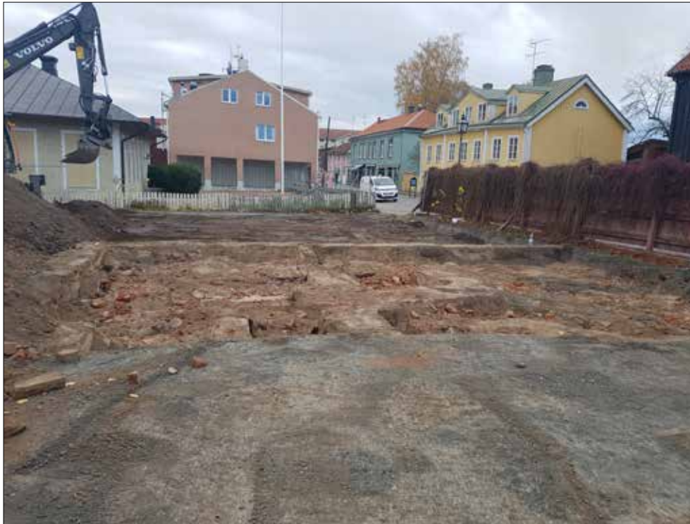
Figur 12. Den moderna husgrunden i schakt 2 syns här från öst. Bakom staketet till höger i bild ligger Nygatan. Schaktbotten i schakt 1 syns i förgrunden.
