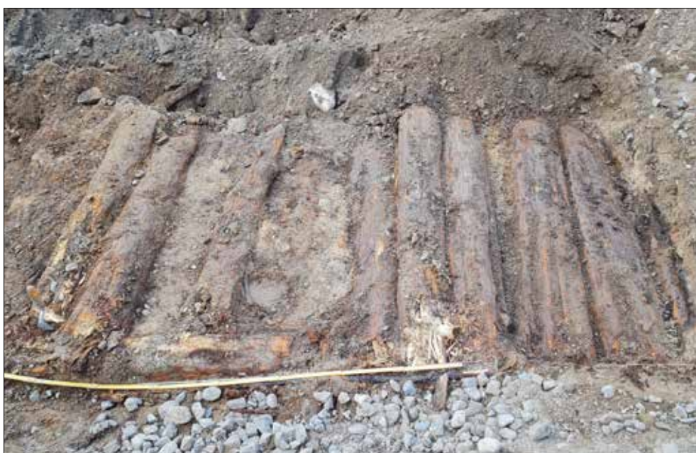
Figur 21. Kavelbro A1005 efter framrensning.
