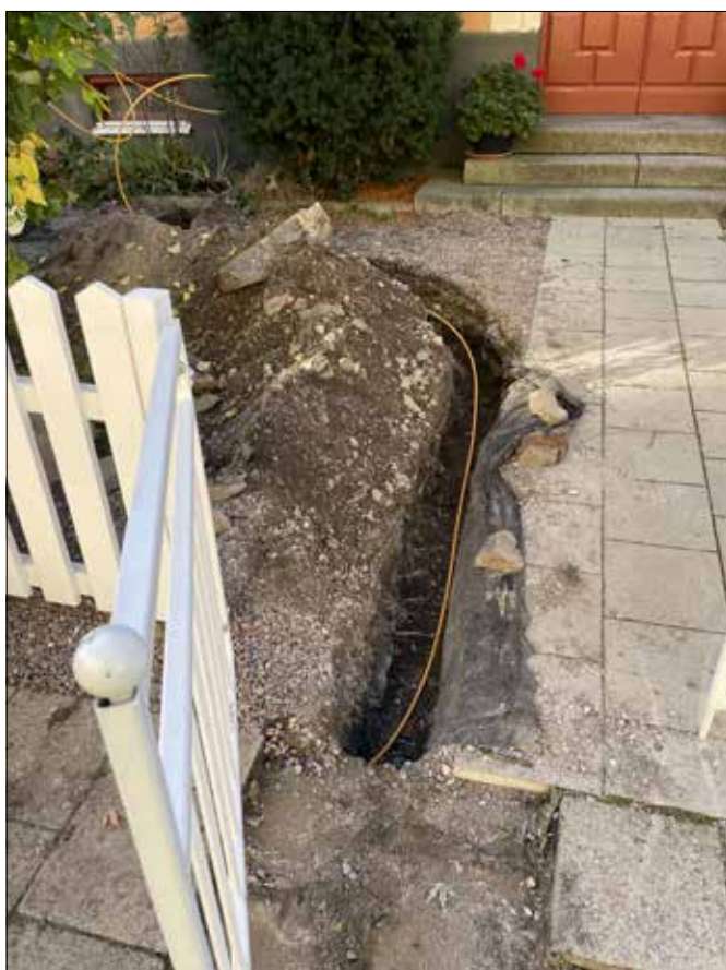
Figur 7. Schaktet gick från Korsgatan in till husväggen över en trädgård. Foto från öster.
