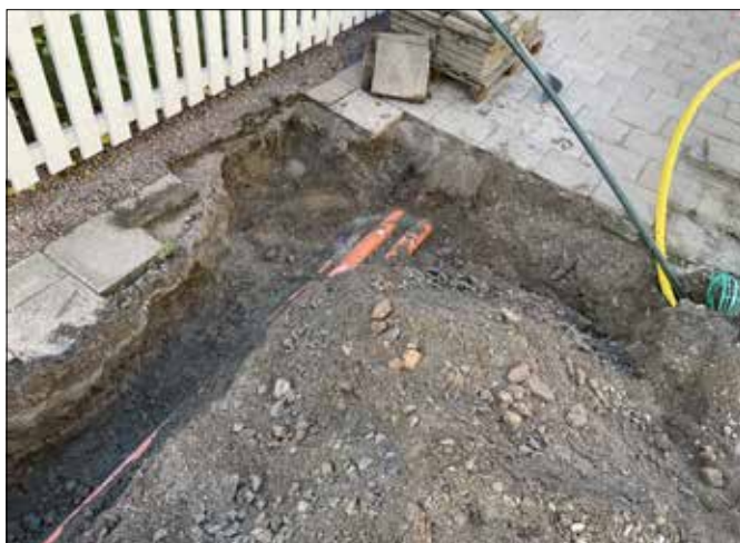
Figur 6. I Korsgatan grävdes fiberkabeln ner bredvid redan befintliga ledningar. Foto från sydöst.
