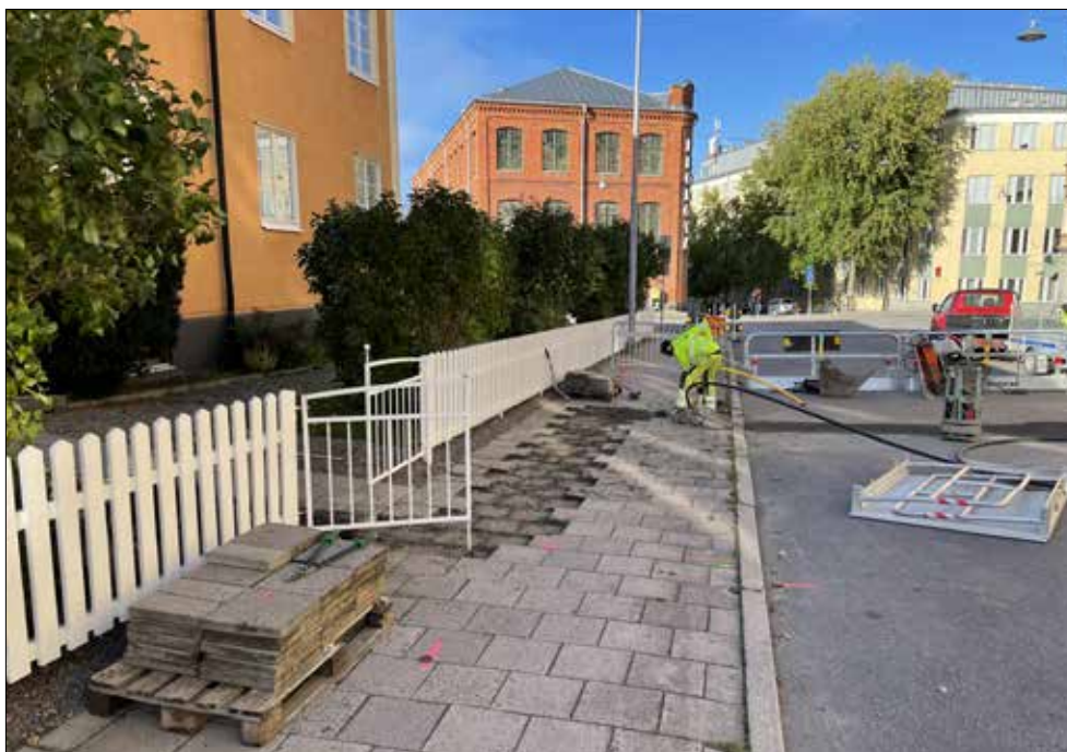
Figur 3. Undersökningsområdet från söder. Plattorna i trottoaren håller på att plockas bort inför grävning.
