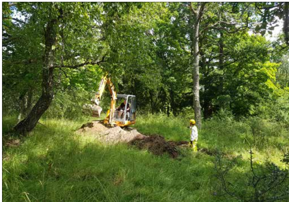
Figur 5. Schaktning i odlingsterrassen som registreras som ett område med fossil åkermark, L2022:10249. Foto från sydväst, från en plats ovanför det cirka 1 meter höga haket ovanför terrassen.
