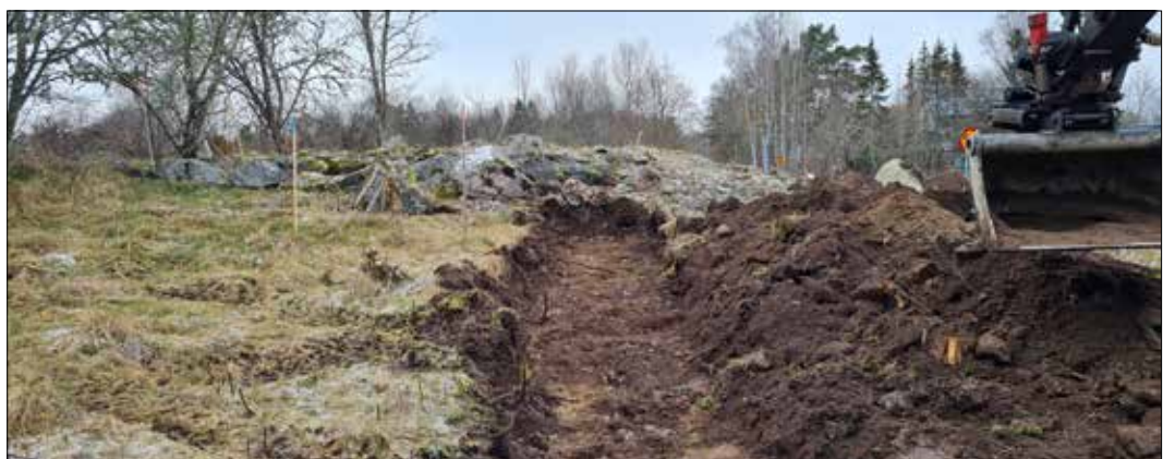
Figur 6. Schakt 395 sett från söder. I bildens mitt ses den kraftiga grunden efter ladugården.
