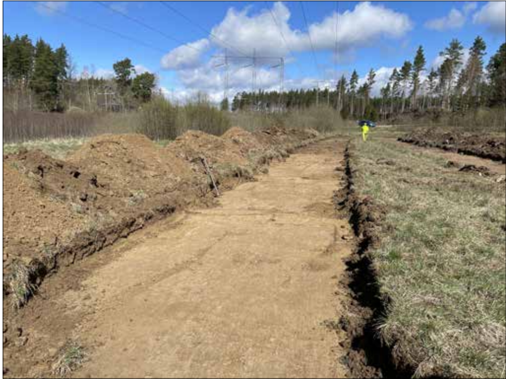
Figur 10. Schakt 18 från söder.
