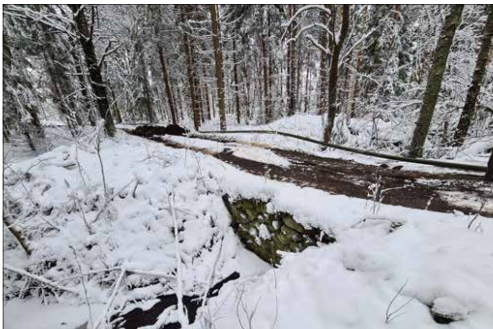
Figur 8. Den enkla bron med utlagd kabel i rör ovanpå. Cirka 10 meter bortom bron har schaktet OS444 öppnats. Foto från norr.
