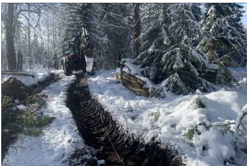
Figur 3. Pågående schaktningsarbete närmast några synliga lämningar av Stenhultet. Foto från öster.
