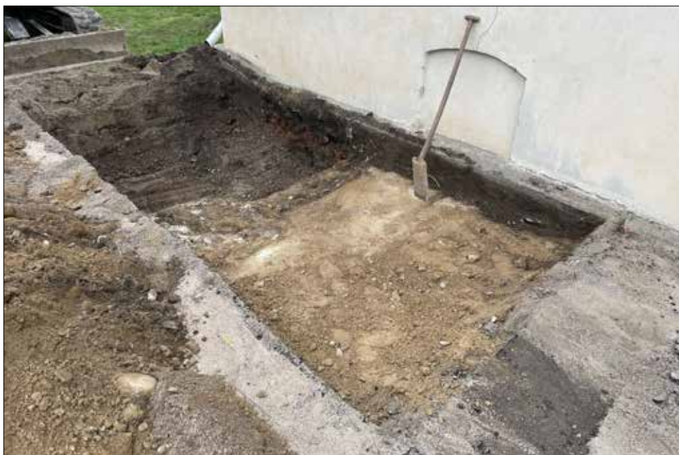
Figur 10. Schakt 3 från nordväst.
