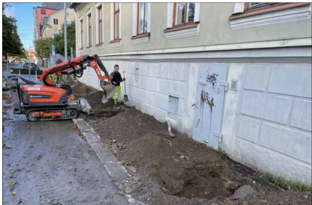
Figur 14. Fyra schakt grävdes utmed Saltängsgatan. Foto från öster.
