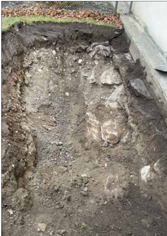
Figur 9. Schakt 1 från norr.
