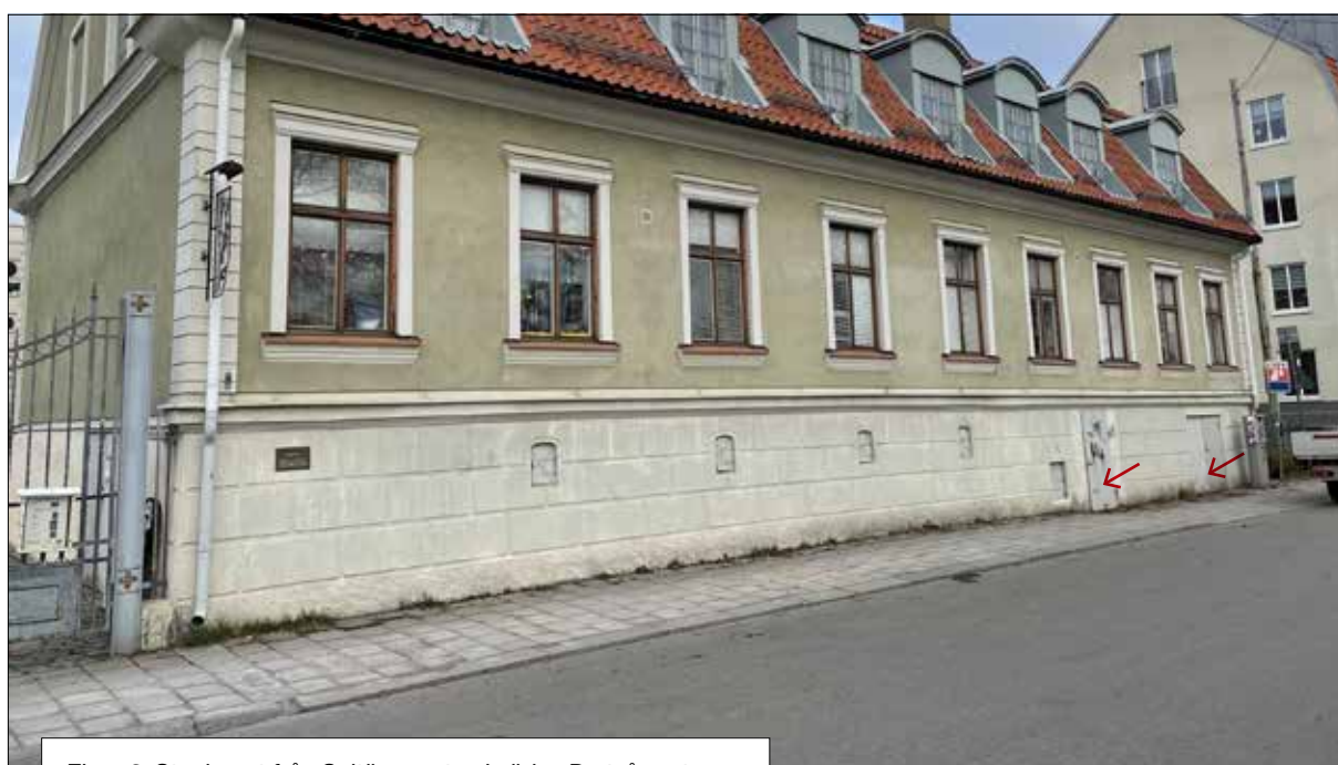
Figur 3. Stenhuset från Saltängsgatan i söder. De två portarna, markerade till höger i bild, ledde in till den aktuella källaren.
