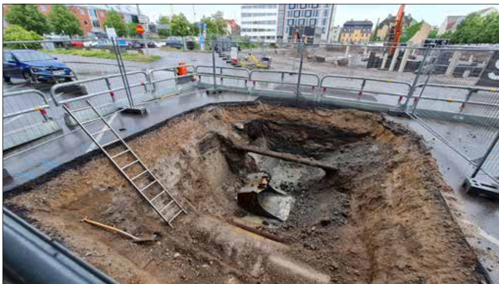
Figur 5. Schaktets norra del. I bakgrunden syns byggarbetsplatsen i kvarteret Skepparen. Foto från norr.
