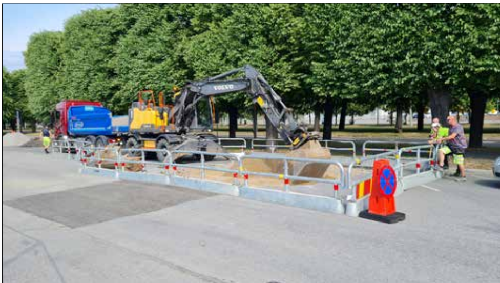
Figur 3. Schaktet började grävas i norr. Foto från sydöst.
