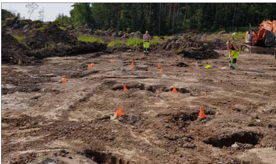
Figur 12. Hus 1 undersöks. Konraderna markerar de takbärande stolphälen Foto från nordnordväst: Camilla Ekblom.
