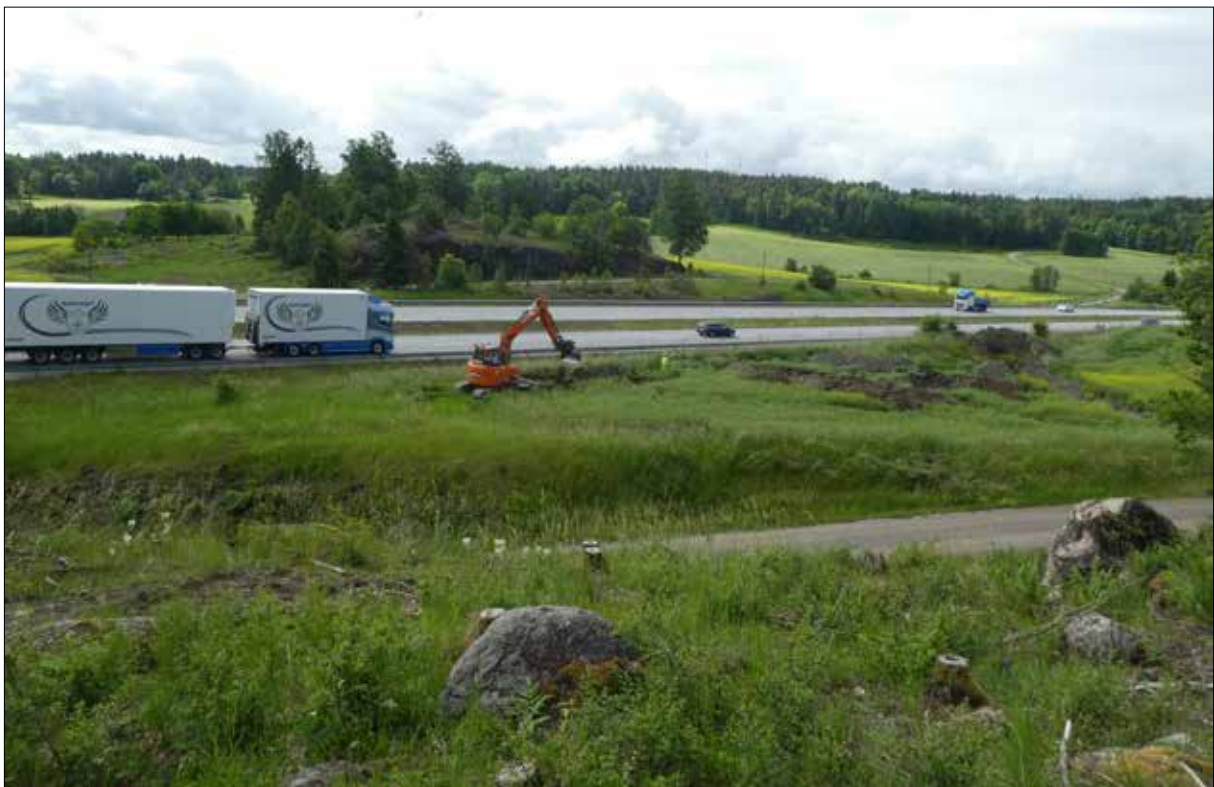
Figur 7. Den södra ytan, där schaktning pågår. I bakgrunden E4 och impedimentet med gravfält L1984:8032. I förgrunden Kumlavägen och delar av den norra ytan. Foto Caroline Strandberg från norr.
