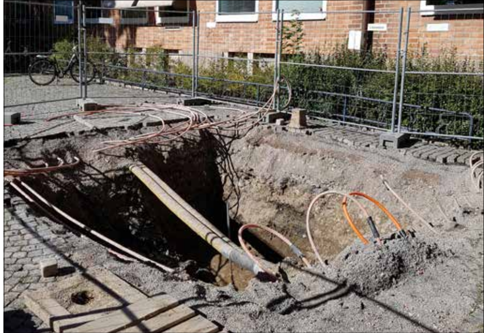
Figur 40. Schakt 9. I norra schaktväggen skimtar bevarade kulturlager. Foto Jonas Ros från sydöst.
