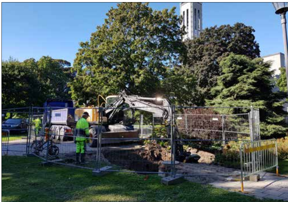
Figur 35. Upptagning av schakt 7B i en av gångstråken. I bakgrunden skumtar stadshusets klocktorn. Foto Jonas Ros från sydöst.
