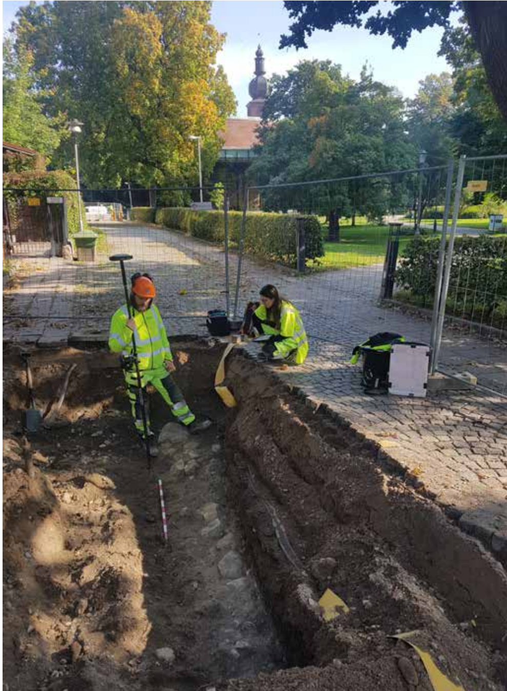
Figur 38. Fredric Wirbrand och Sigourney Nina Navarro dokumenterar stenlagd yta A428 och underliggande konstruktionslager A437 i schakt 8B. Foto från väster.
