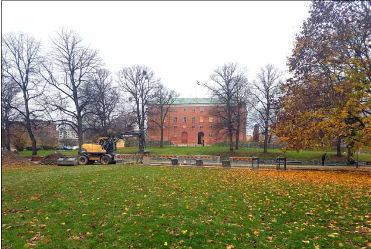
Figur 24. Schakt 12 togs upp mellan schakt 3 och 5, parallellt med en gång- och cykelbana intill Svartån. På andra sidan Svartån syns sig Västerås slott. Framför schaktet står skulpturen "Våga" med sina bronshästar. Foto från öster.
