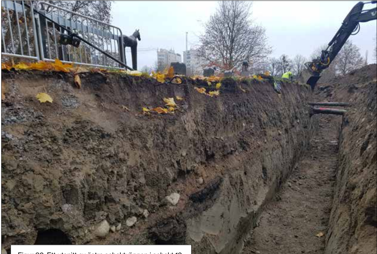
Figur 30. Ett utsnitt av östra schaktväggen i schakt 12. Ovanför skymtar skulpturen "Våga". Foto från norr.
