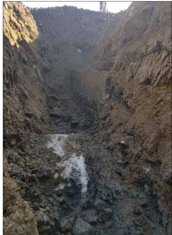
Figur 20. Mitt i schakt 11 påträffades en relativt modern spont. Sannolikt har denna haft ett samband med konstruktionen av åskoningarna. Foto från norr.
