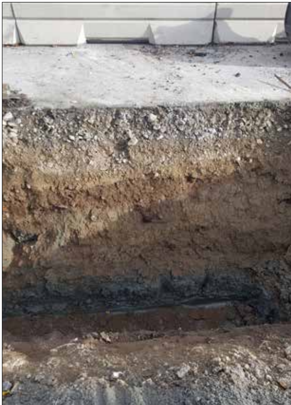
Figur 19. I östra schaktväggen av schakt 11 skymtar ränna A559 under det bruna stråket som utgjort äldre markyta A567. Foto från väster.
