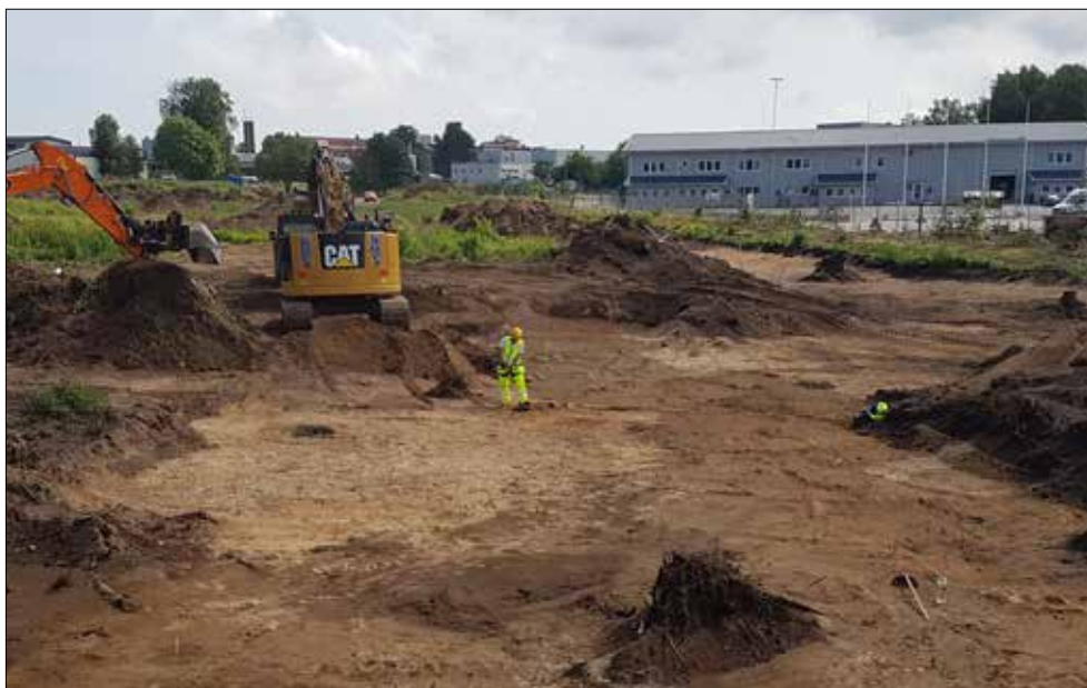
Figur 11. Avbaning av matjordslagret. Från väster. Foto Reidar Magnusson.
