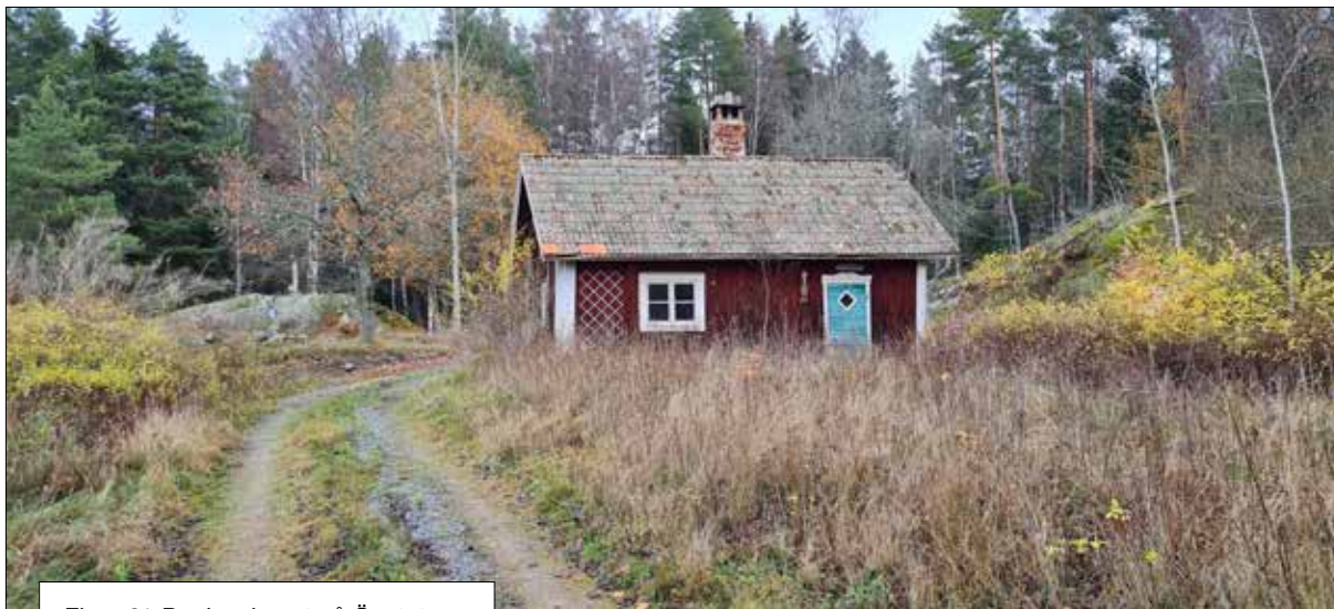
Figur 21. Boningshuset på Önstatorp. Foto från nordväst.
