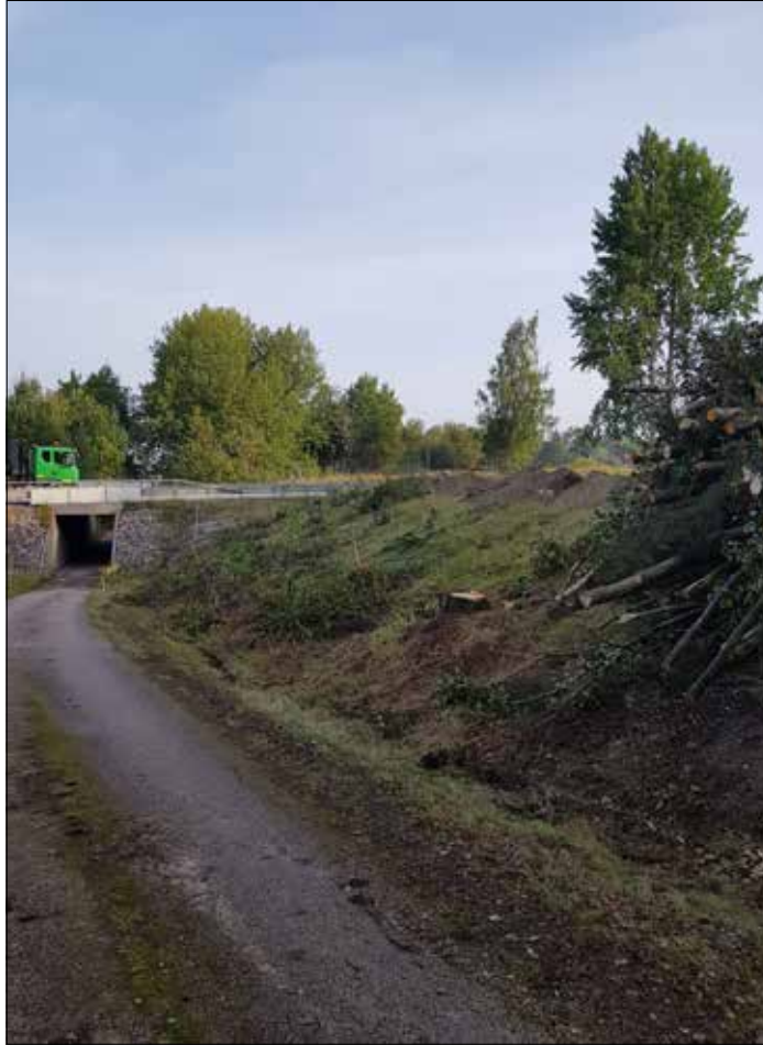
Figur 3.4. Slänt i västra delen av östra förundersökningsområdet. Foto Camilla Eklom från söder.
