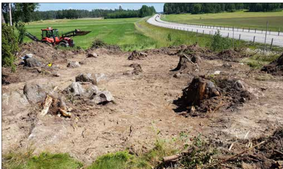
Figur 2.2. Det stora schaktet S251. Foto Henrik Runeson från väster.
