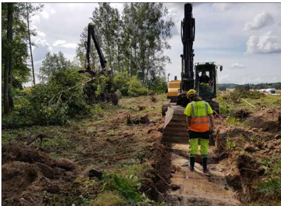
Andreas Forsgren övervakar schaktning vid lokal 3 i Sörberga. Foto Camilla Eklom.
