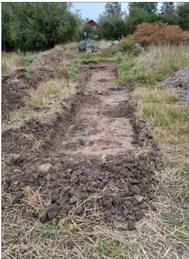
Figur 5.4. Schakt S32520. Foto Christian Gatti från väster.
