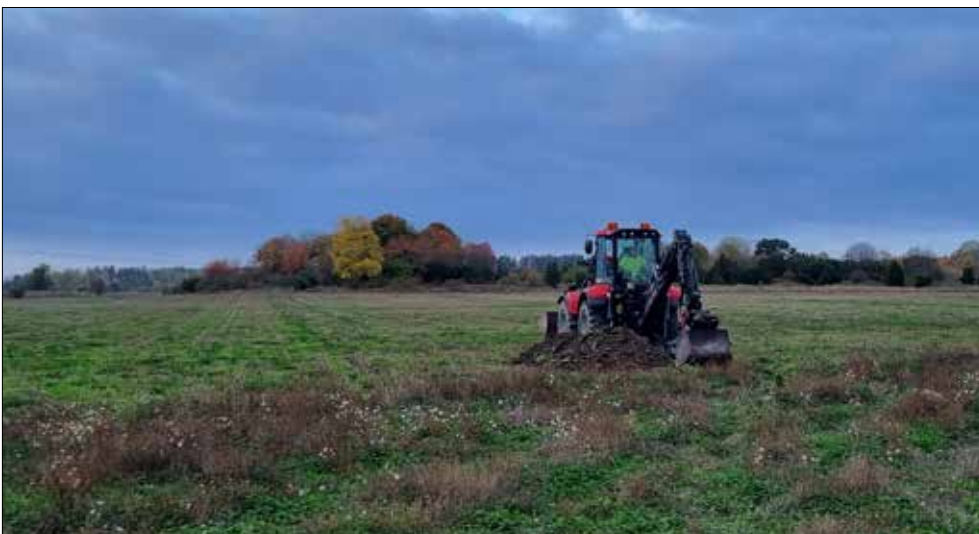
Figur 7. Schaktning vid område A. Vänster om maskinen, på impedimentet, är gravfält 2002:266 även känd som Lötbacken. Foto från norr: Christian Gatti.
