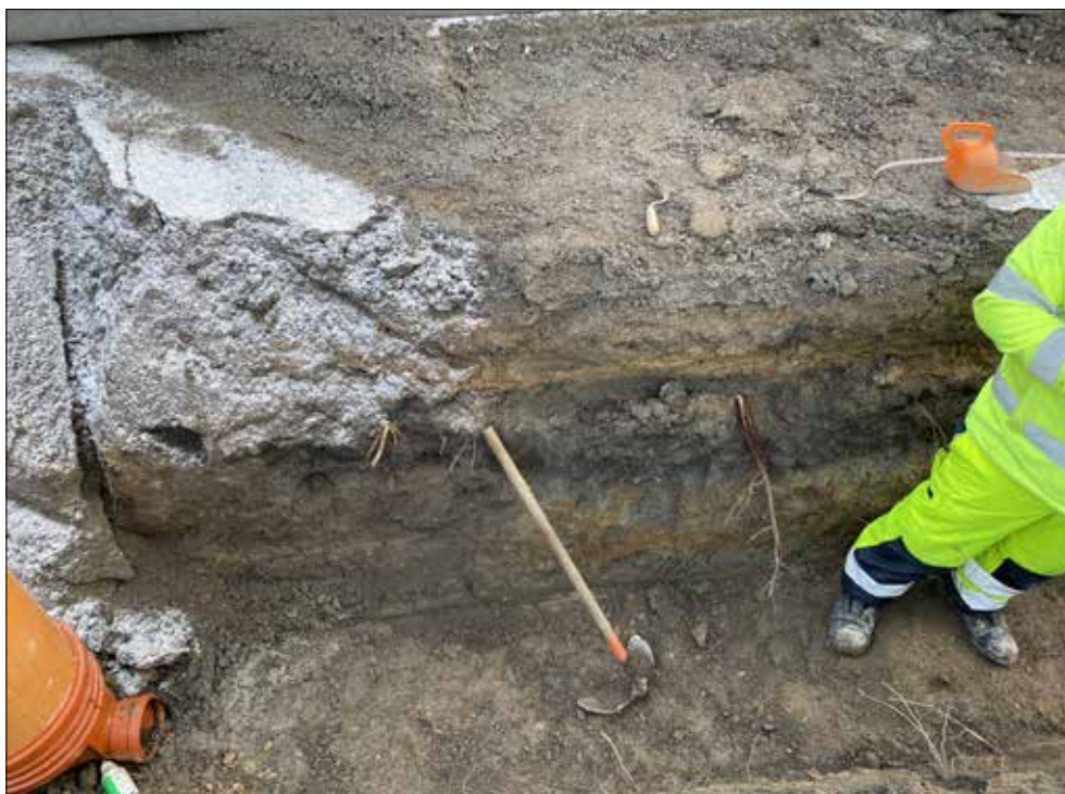
Figur 7. Lagerföljden syns i östra schaktväggen. Foto från väster.
