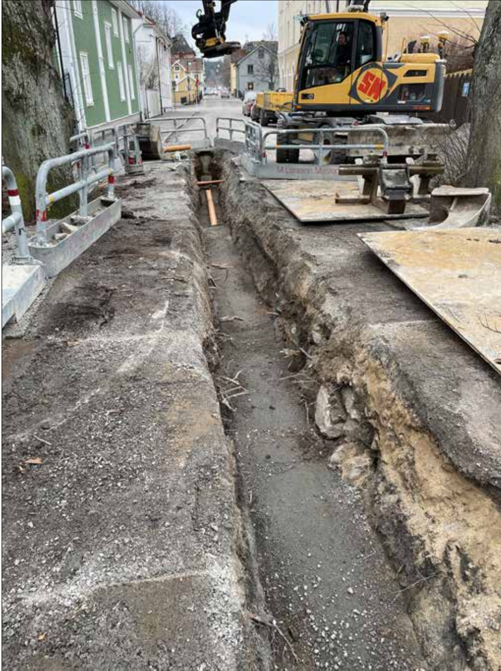
Figur 9. Översikt, schaktet från norr. Här färdiggrävt och delvis igenfyllt.
