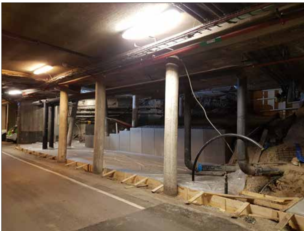
Figur 21. Undersökningsområdet då teknikrummet hade börjat byggas. Foto från nordöst.
