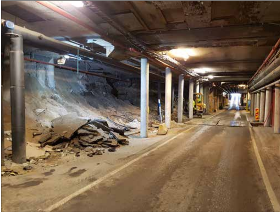
Figur 6. Citytunneln. Undersökningsområdet låg till vänster på bilden. Foto från söder.
