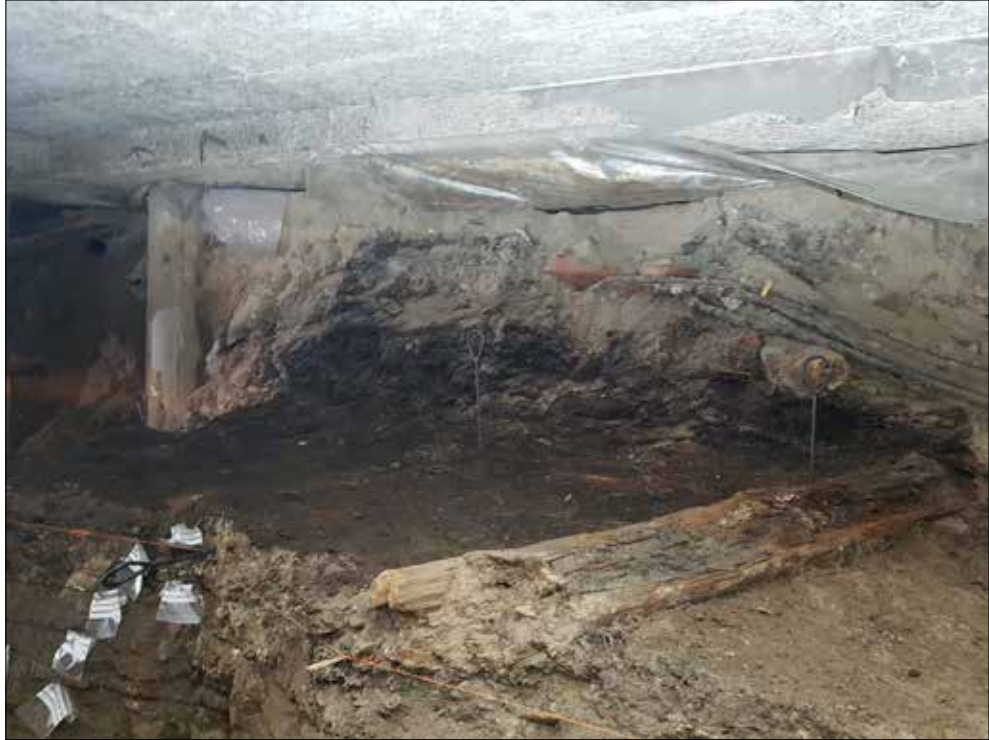
Figur 15. Syllstocken A2, som avgränsat Hus 2 mot norr. Golvnivån i huset ses till vänster om syllstocken. Foto från nordöst.
