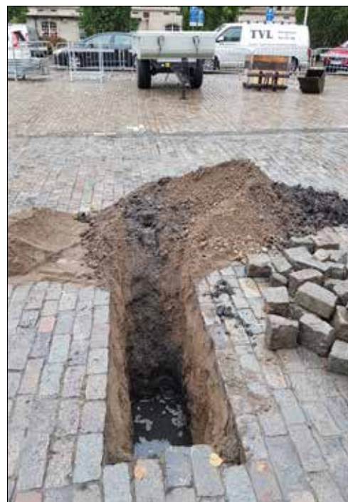
Figur 75. Schakt 19. Schaktet fylldes delvis med vatten. Foto från sydöst.
