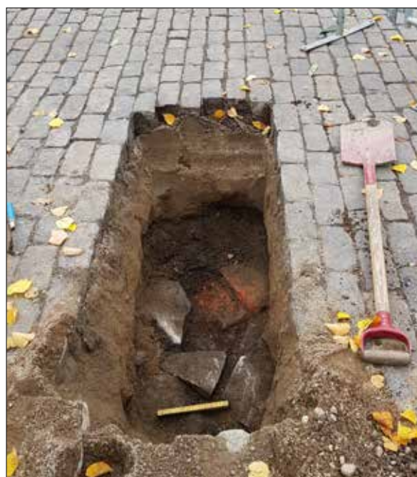
Figur 70. Grundstenarna i schakt 17. Foto från sydöst.
