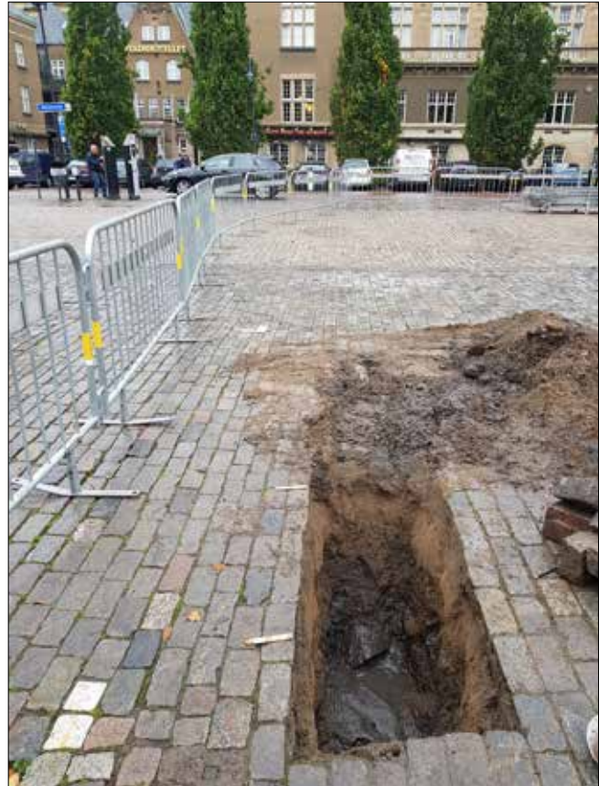
Figur 73. Grundstenarna i schakt 18. Foto från sydöst. Sektionen upprättade över den vänstra schaktväggen. I bakgrunden ses Stadshotellet.
