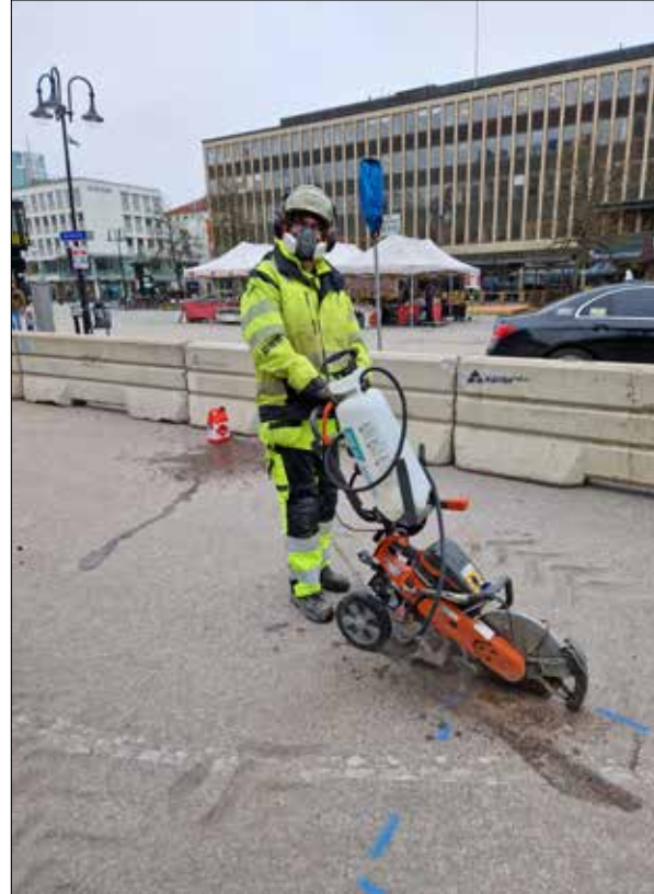
Figur 109. Asfalten skärs av Nichlas Bergman vid Västerås stad.
