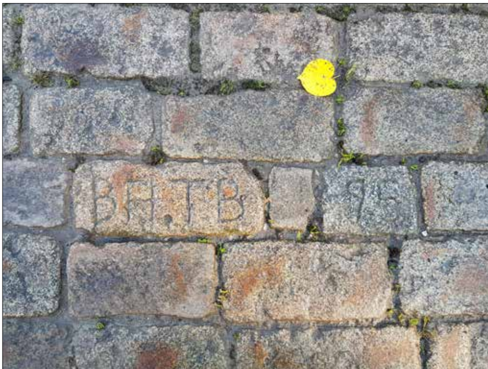
Figur 41. På Stora torget fanns gatstenar med inskriften BA.TB 95. Det är förkortningar, initialerna, till namnen på de som lade stenarna på torget 1995 i samband med den förra ombyggnationen av Stora torget.
