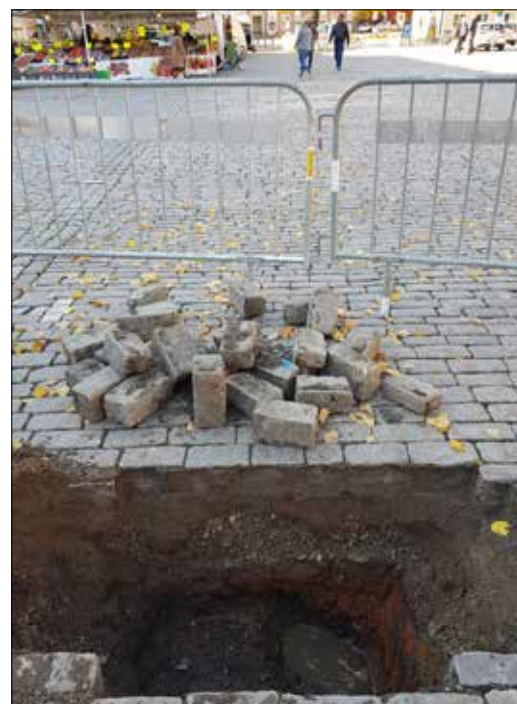
Figur 89. Schakt 28 med det rödbruna krossade teglet. Foto från öster.
