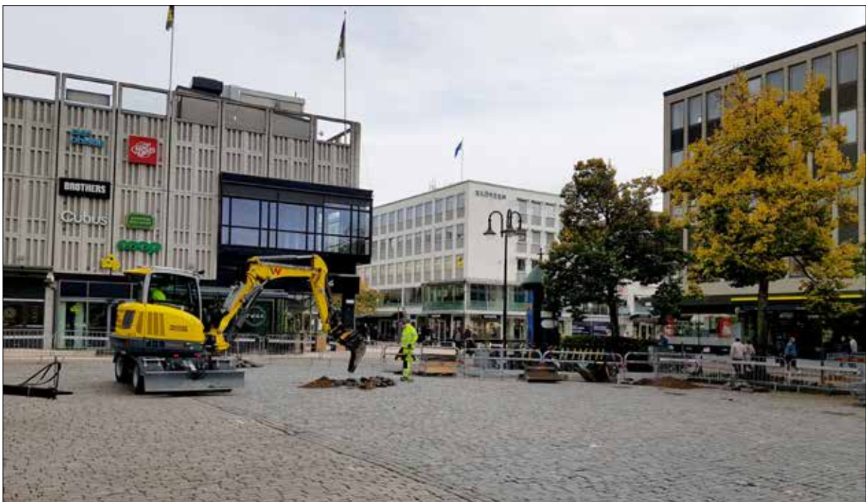
Figur 37. Översikt, ett schakt tas upp på Stora torget. Foto från söder.
