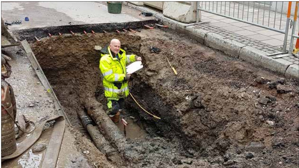
Figur 6. Arbetsbild som visar Jonas Ros i schaktet. Foto från sydöst.
