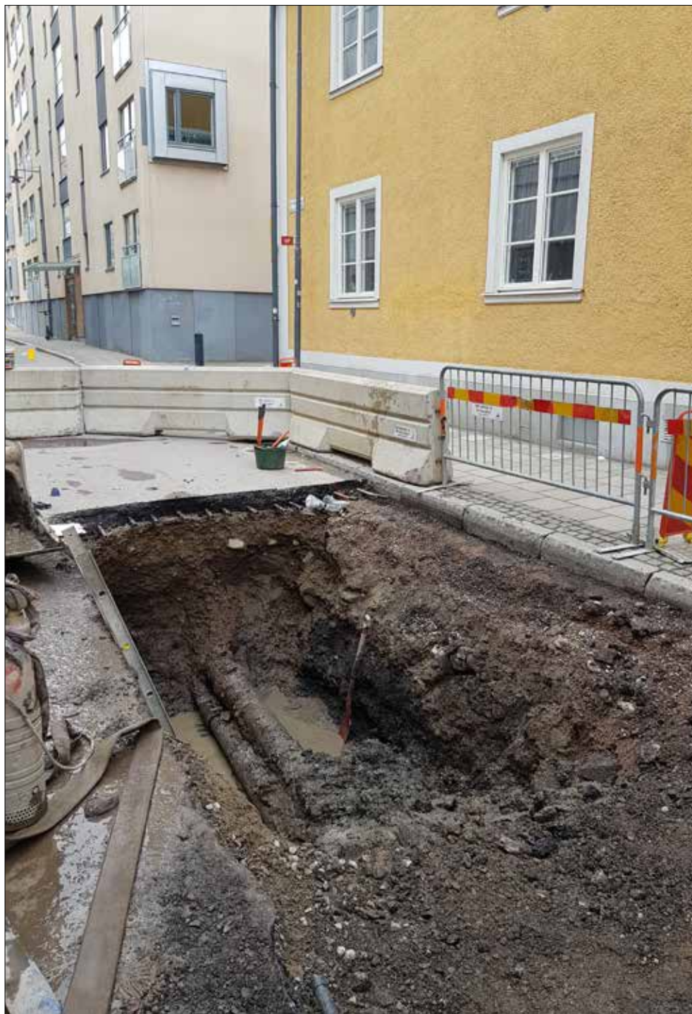
Figur 7. Översikt som visar schaktet i Övre Kungsgatan. Vatten i schaktets botten var ett problem vid undersökningen. Foto från sydöst.
