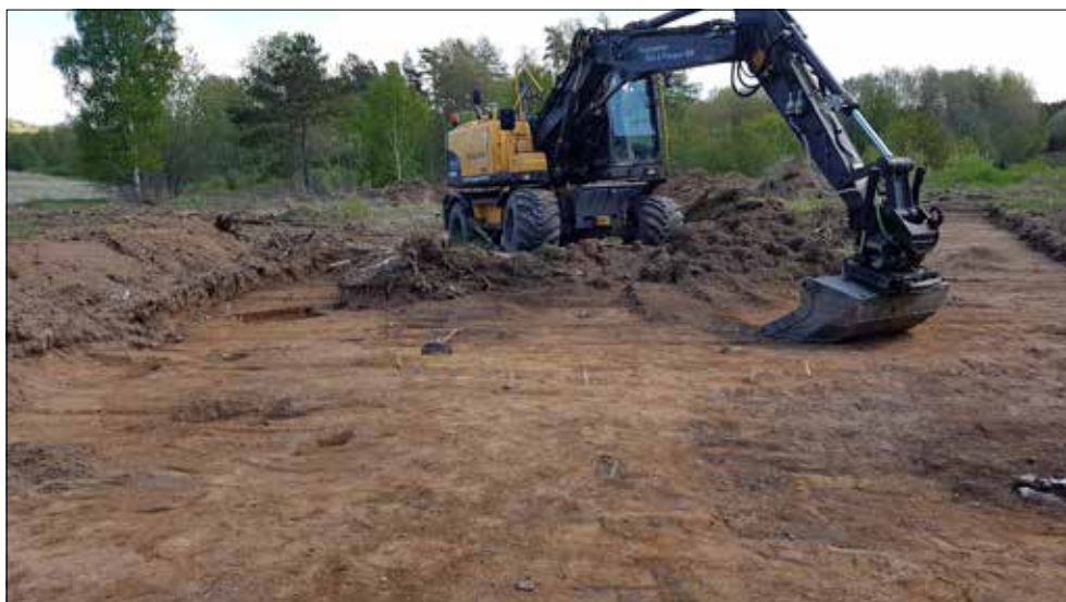
Figur 4. Avbaning med grävmaskin på L2008:7532.
