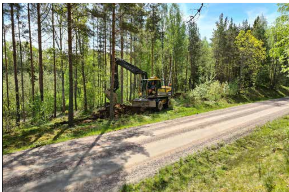
Figur 4. Sökschaktning i utredningsobjektets norra del. Foto från nordväst.
