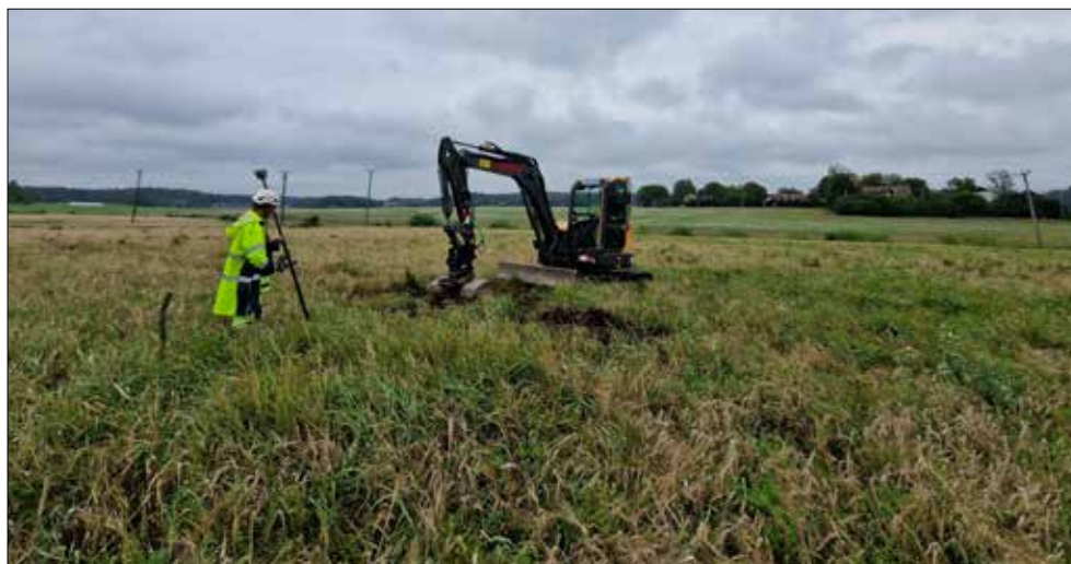
Figur 2. Schaktning vid objekt 12, från söder. Foto Ruth Rudenlöv.
