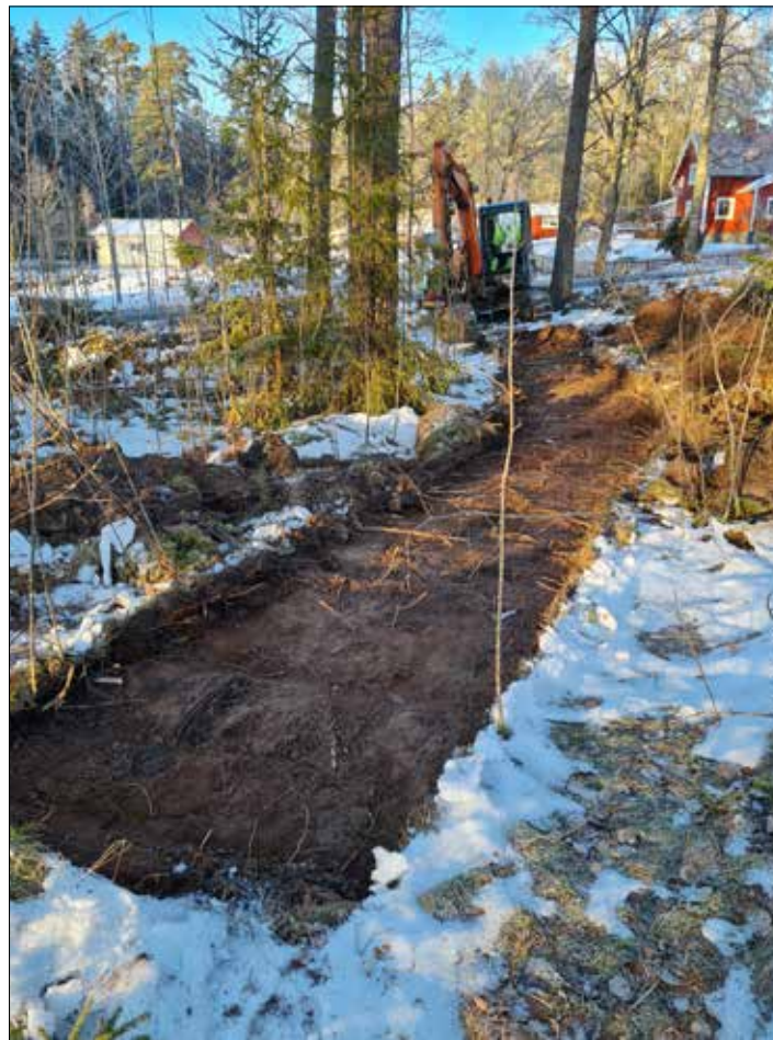
Figur 19. Schakt 391 i norra delen av boplatssläge 1 fotograferat från sydöst.
