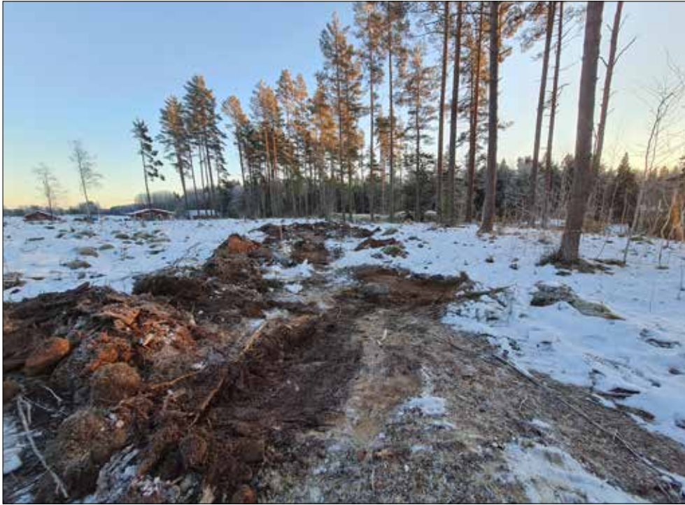
Figur 25. Schakt inom boplatsläge 3 fotograferat från nordväst.
