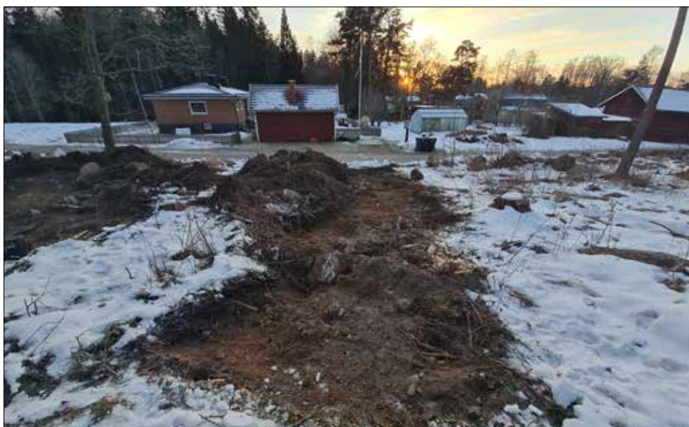
Figur 21. Schakt 2 med anläggning 1 synlig i norra änden av schaktet. Fotograferat från norr.
