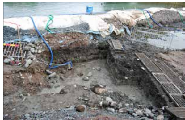
Figur 8.24. Invallad yta som undersöktes på Strandvägen 2010. Den invallade ytan på strandvägen torrlades med hjälp av eldrivna dränkpumpar. Foto: Fredrik Hallgren.
