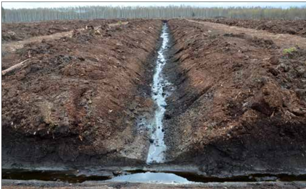
Figur 7.61. Dikning inför torvbrytning med grävtorvsmetoden, flera meter djupa diken grävs mellan tegarna. Foto: Fredrik Hallgren.
