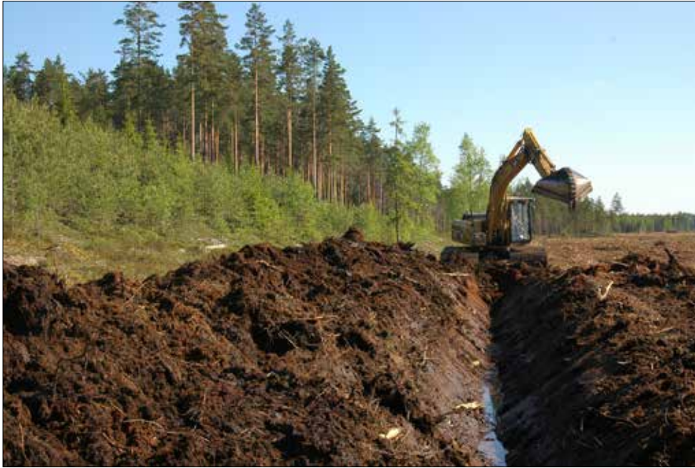
Figur 8.28. Schaktövervakning av dikesgrävning i Vännmuren, intill stenåldersboplatsen L1950:5935 (Hovanta 2008:figur 33).
