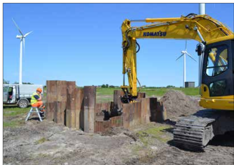
Figur 8.63. En kassun placeras ut och trycks ner i lagerföljden vid Syltholm. Foto: @ Museum Lolland-Falster.
