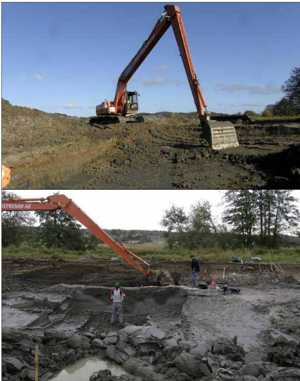
Figur 8.26. Vid undersökningen vid Grönån så användes av säkerhetsskäl grävmaskin med lång räckvidd (Nordqvist 2011:figur 5 och 18).
