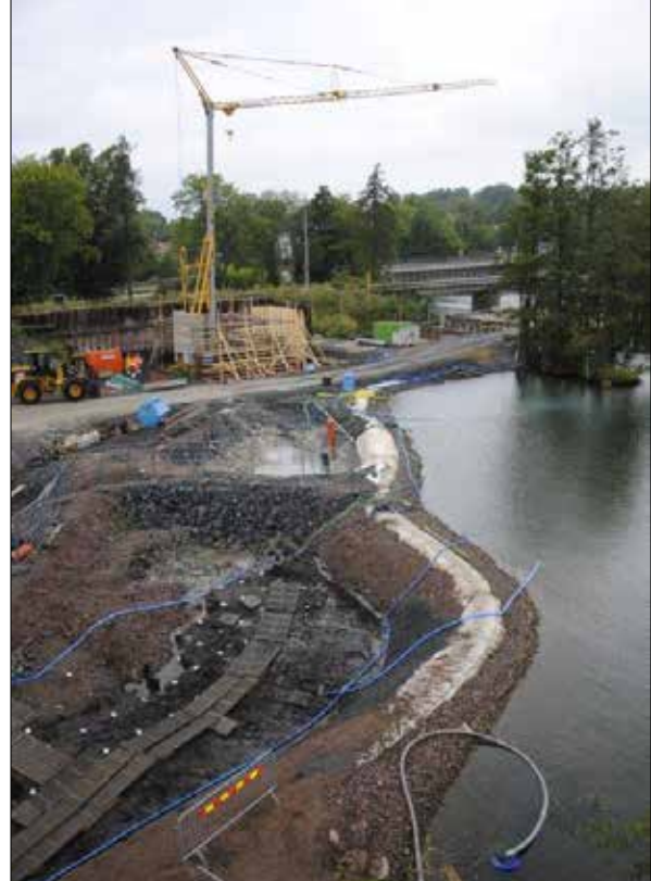
Figur 8.22. Vid undersökningen på Strandvägen 2009–2013 byggdes en vall mot Motala Ström, för att möjliggöra undersökning av konstruktioner och utkastlager på den strömmens botten (Molin under arbete).
