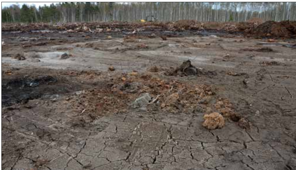
Figur 7.62. Schaktbotten av yta som schaktats ner med grävtorvsmetoden i Ekebymossen. I förgrunden sticker ribbor från katsa 1 upp. I bakgrunden anas en gul och svart grävmaskin uppe på schaktkanten. Foto: Fredrik Hallgren.
