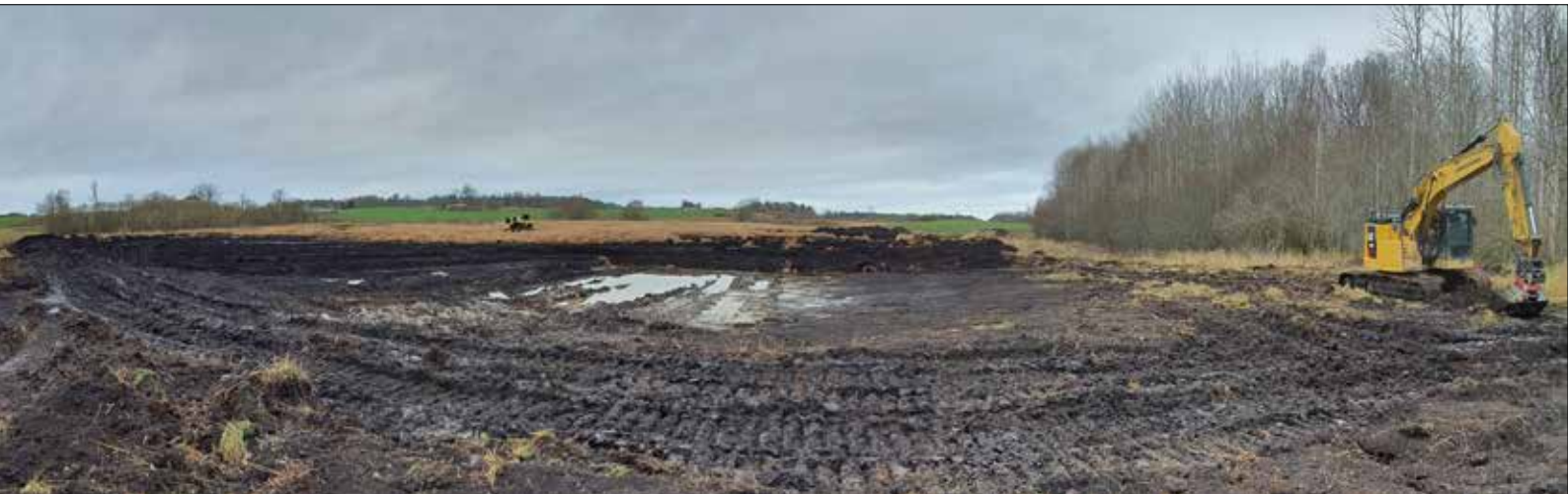
Figur 7.18. Den schaktade ytan för anläggande av våtmark vid Skarby väster om den utdikade Skarbysjön, vy mot norr. Huvuddelen av schaktarbetet gjordes av bulldozern som syns i bakgrunden. Som en följd var hela den schaktade ytan täckt av spår av larvband. Foto: Fredrik Hallgren.
