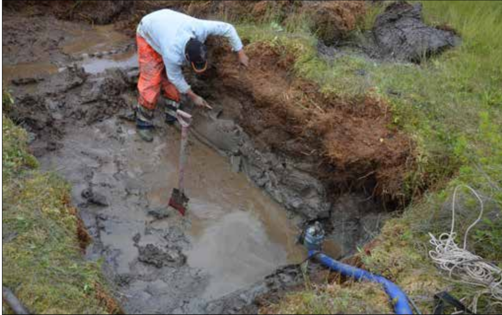
Figur 8.58. Vid grävningen i våtmarken i Bäckeby användes en eldriven slampump, som drevs av ett bärbart dieselaggregat, för att pumpa bort vatten från schakten. Foto: Fredrik Hallgren.
