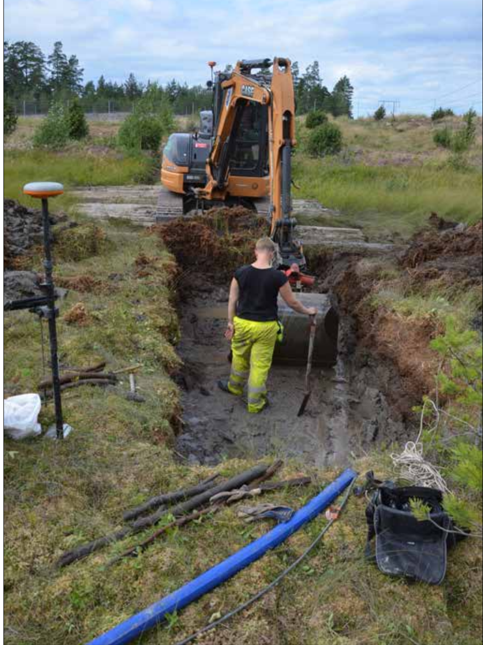
Figur 8.57. Schaktning i våtmarken vid Bäckeby, Östergötland 2019. Foto: Fredrik Hallgren.
