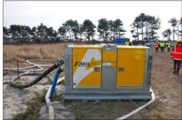
Figur 8.66. Vattenpump för sänkning av grundvattennivån, Syltholmprojektet. Foto: Fredrik Hallgren.
