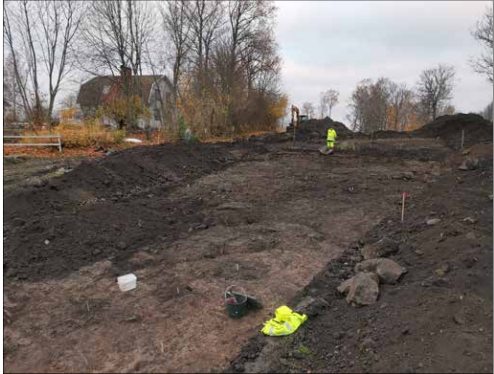
Figur 25. Schaktning i kulturlager A2672, från sydöst. Foto Frida Albinsson.
