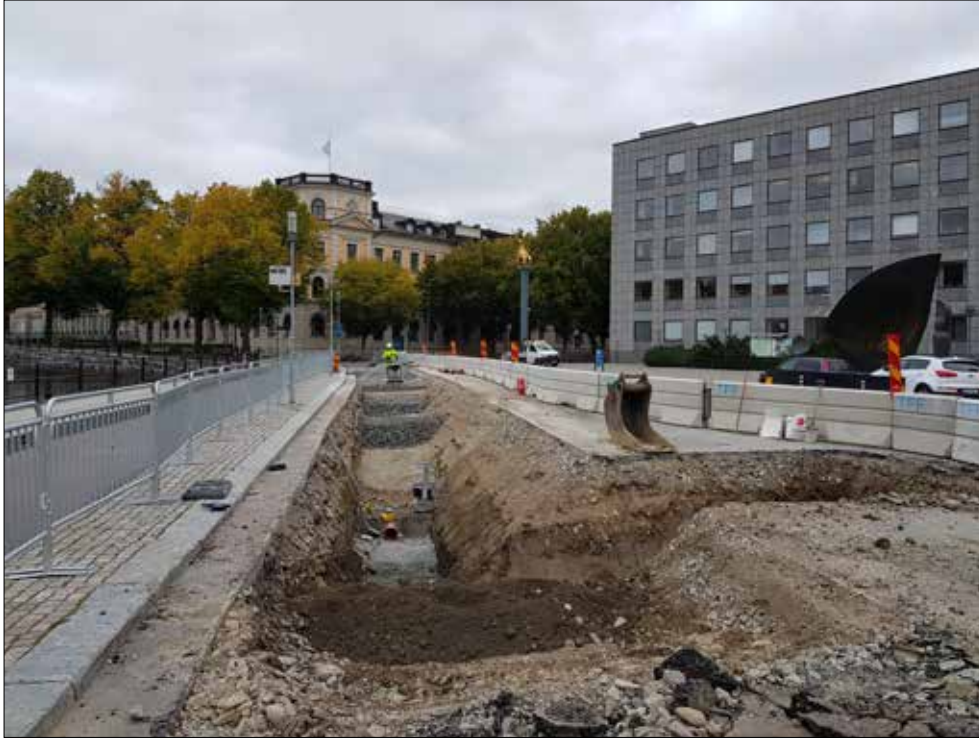
Figur 53. Översiktsbild som visar delar av schakt 2. Allteftersom ledningarna lades ned fylldes schaktet igen. Foto från söder.
