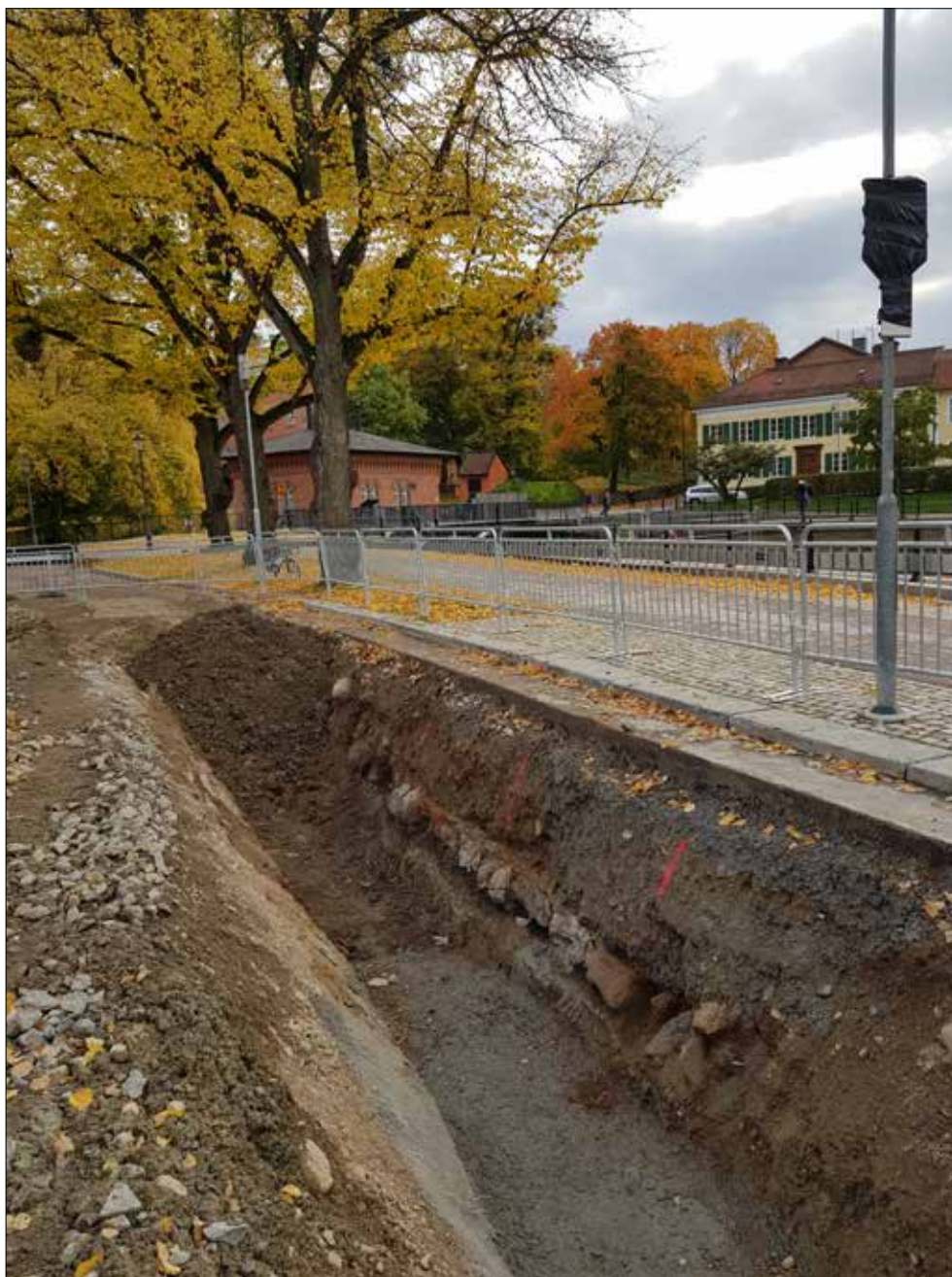
Figur 56. Delar av grundstenarna till huset, A11, i plan och i schaktväggen. I bakgrunden ses Svartån, Turbinhuset och Västerås slott. Foto från nordöst.
