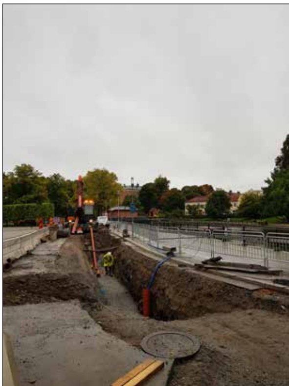
Figur 34. Översiktsbild som visar schakt 2. Foto från norr.
