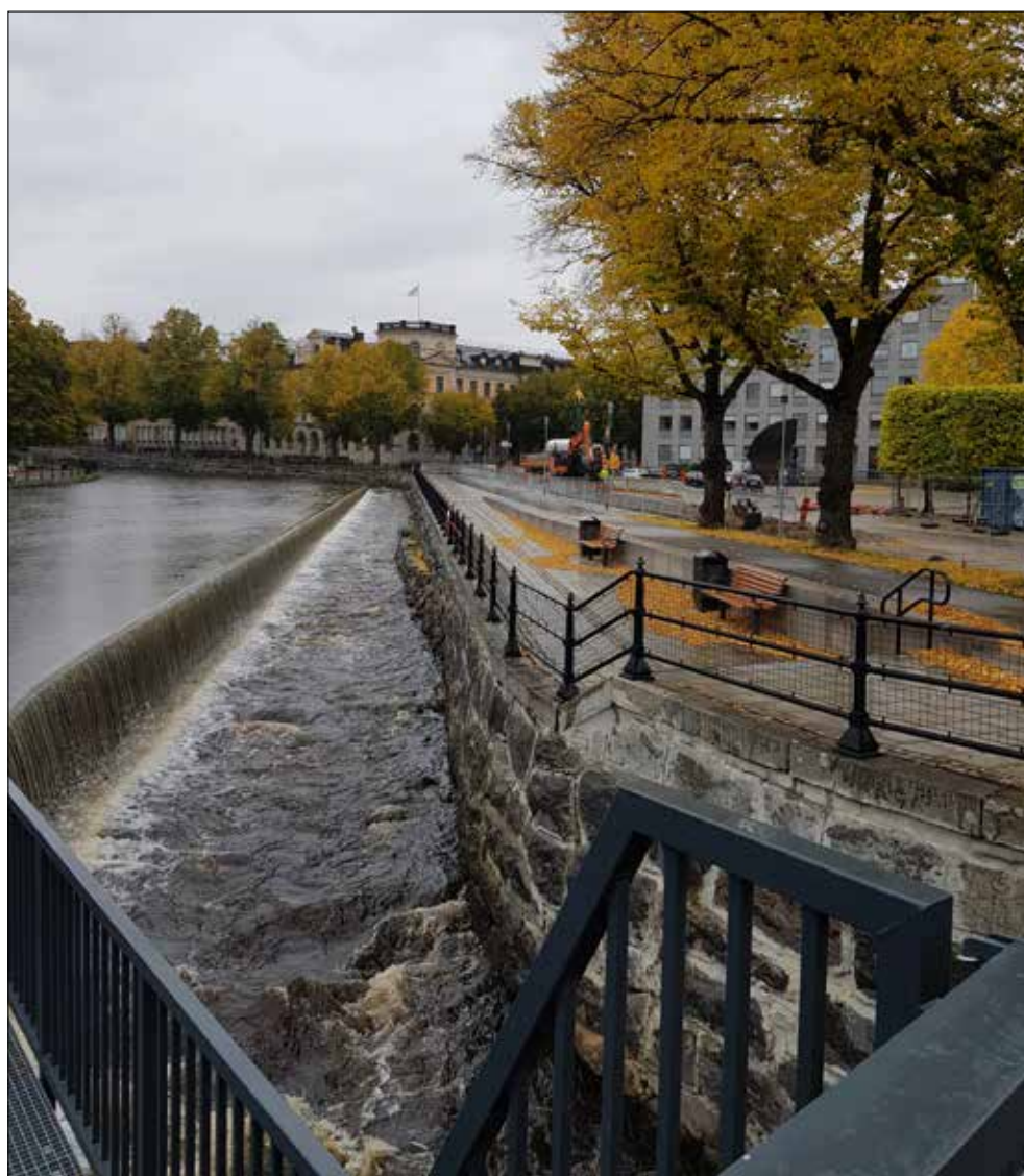
Figur 63. Översikt som visar delar av undersökningsområdet och delar av Svartån med faunapassagen där fiskar kan simma förbi Turbinbrons damm. Foto från söder.
