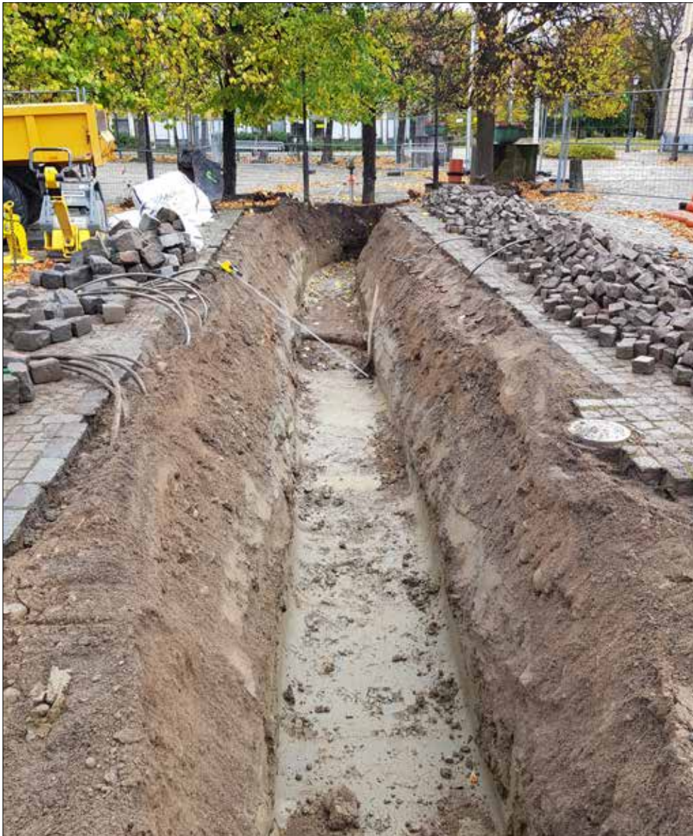
Figur 67. I schakt 5 fanns endast lera under bärlagret. Foto från väster.
