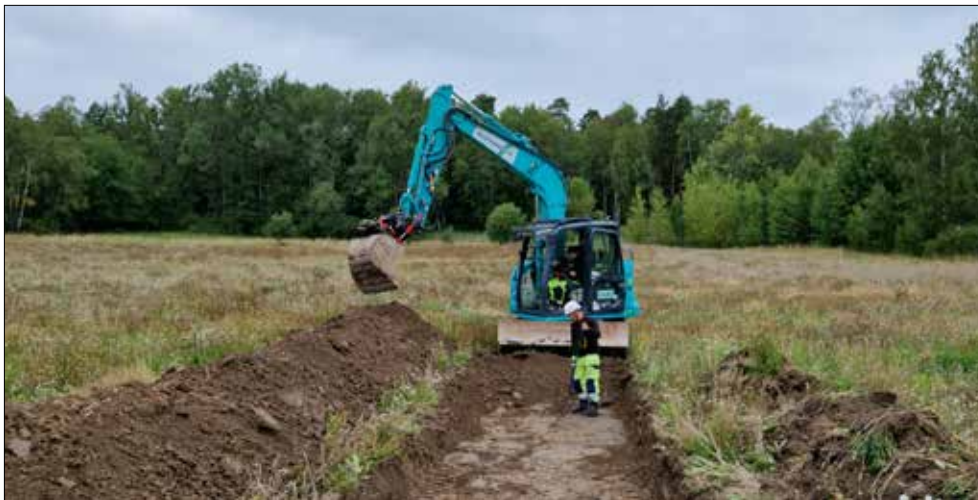
Figur 5. Schakt i åkermark. Från söder.
