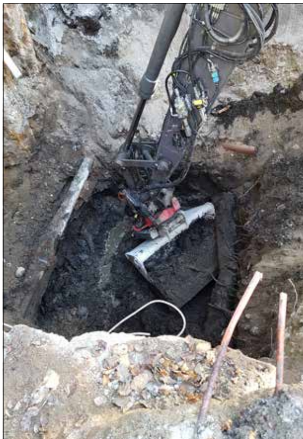
Figur 72. I botten på schakt 5 fanns en liggande stock, A19, varifrån ett dendrokronologiskt prov togs. Foto från nordväst.
