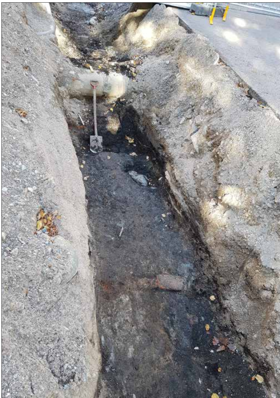
Figur 42. Lämningsarna av hus 6. Intill golvet A20 fanns tegelstenar, A21, som utgjorde resterna av en avgränsning av en eldstad. Foto från söder.
