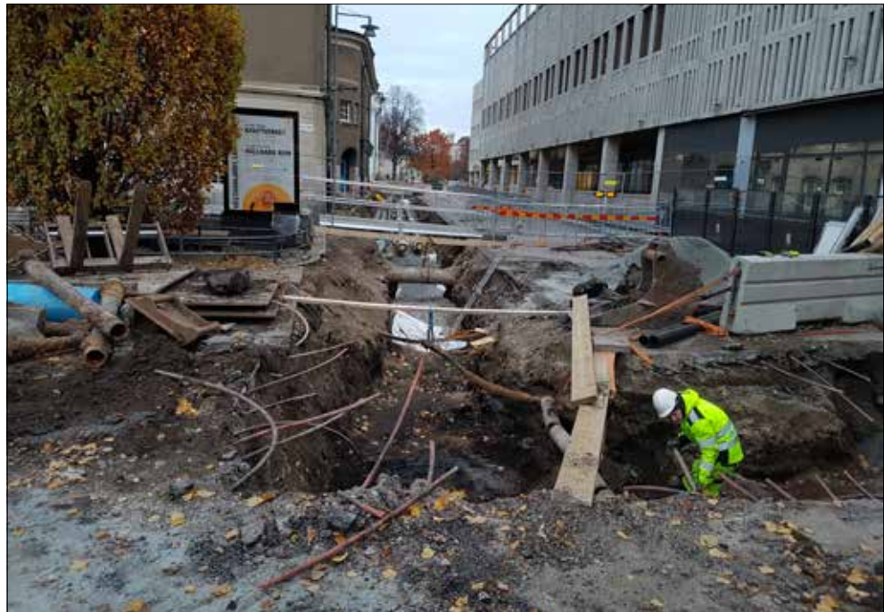
Figur 58. Översikt över schakt 4, med schakt 5 till höger. Foto från söder.
