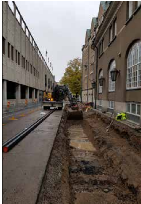
Figur 23. Delar av schakt 4 då fähuset, hus 2, hade schaktats bort. Det var ofta vatten i schakten. Foto från nordväst.
