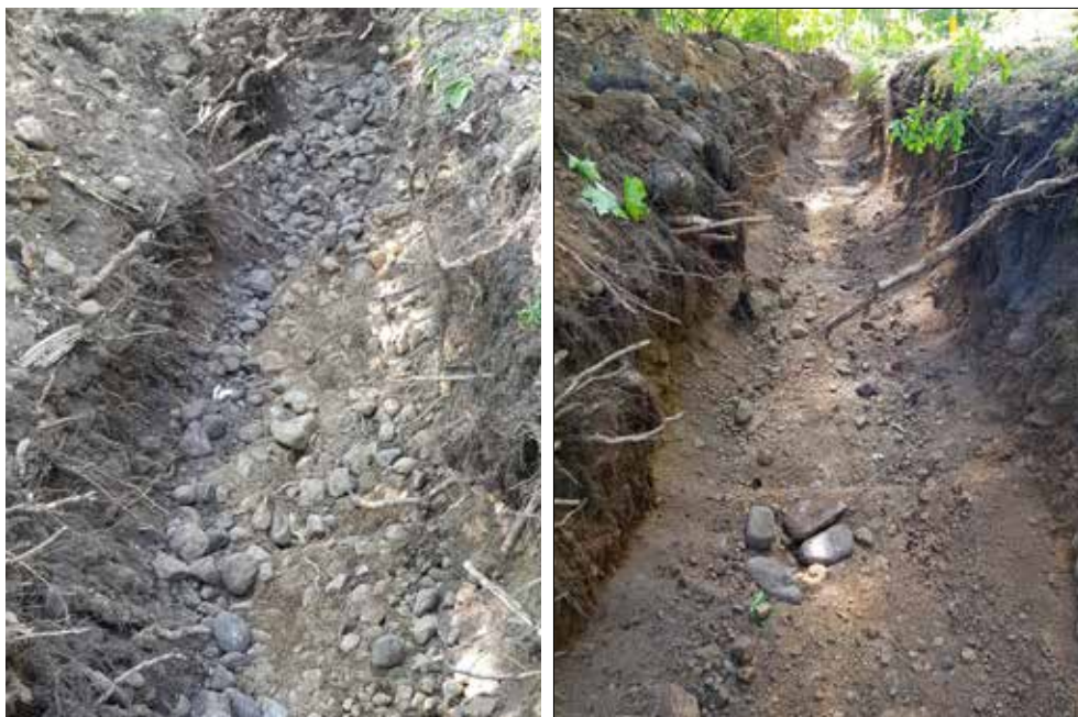
Figur 5. Exempel på ett par avsnitt av schaktet uppe på åsen. Foto från norr.
