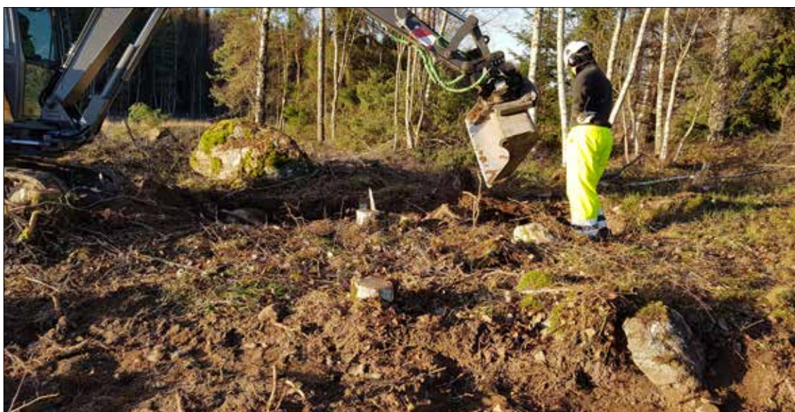
Figur 23. Schaktning vid stensträng A375. Foto från sydost.
