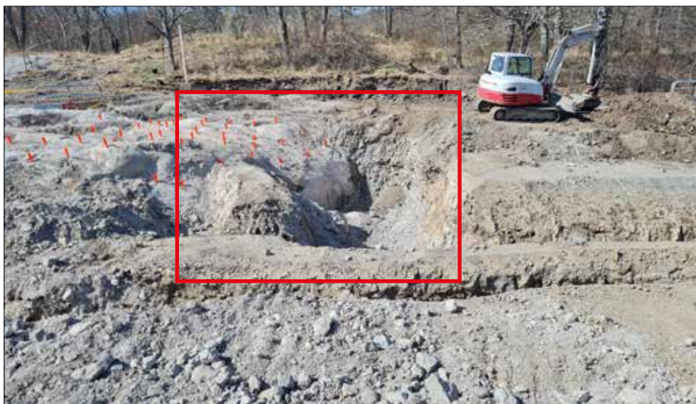
Figur 7. Röd rektangel visar djupschakt för pumpstation. I schaktet framkom berg som ska sprängas (orange borrkoner). Området för fornlämningen/bytomten syns i bakgrunden som ett skogsområde. Foto från öster.
