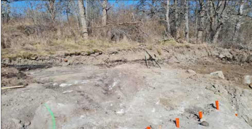
Figur 9. Södra delen av schaktet (till vänster i bild) med mörkt lager följt av berg i dagen, norra delen av schaktet (till höger i bild) med tjocka omrörda lager följt av lera.
