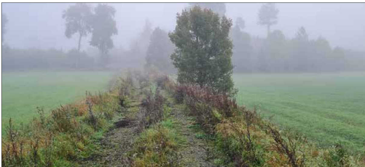
Figur 19. Vägbanken objekt 8 sedd från öster.
