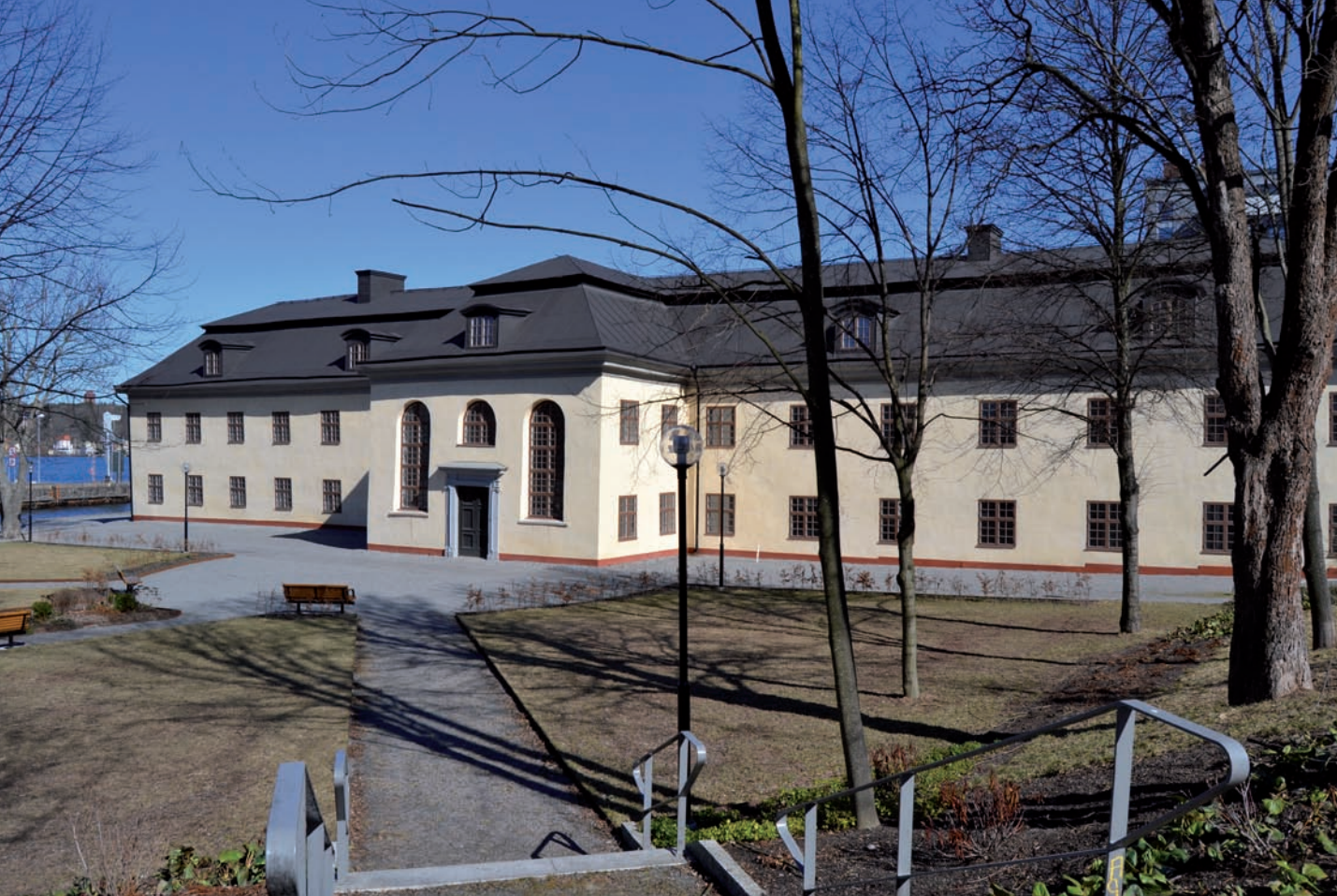
Bevarad byggnad från Danvikens hospital i Henriksdal i Nacka. Foto Anna Lihammer 2012.
